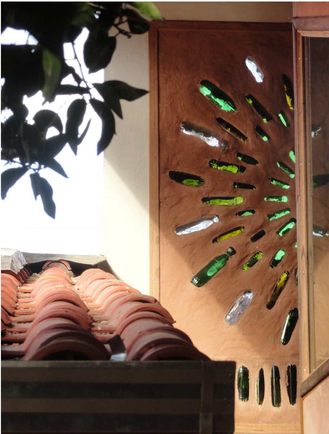
Vegetalis, Infantário, 2014. Paramento em armação com mandalas de garrafas, preenchido com argila, cimento e bambu.
