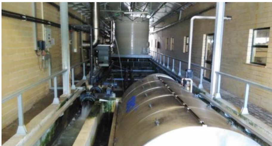
Figura 25: Filtro de tambor rotativo e biofiltro (fotografia tirada por Tiago Foz)
