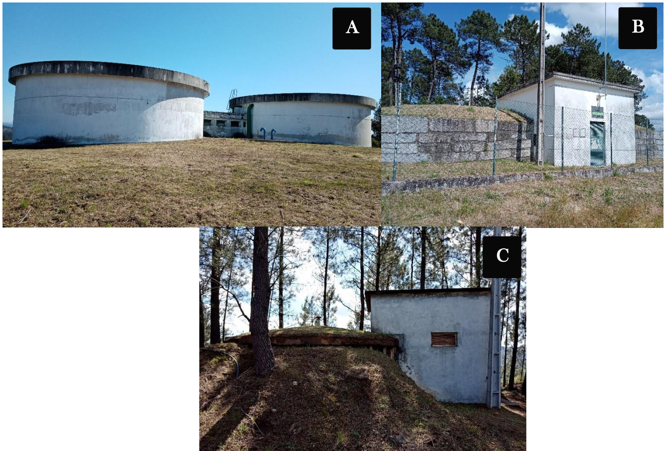
Figura 8 Exemplos dos 3 tipos de reservatórios caracterizados quanto à sua localização (apoiados, semienterrados e enterrados) na empresa Águas do Norte. A - Reservatório apoiado da Serra de Água e Leite, em Amarante; B – Reservatório semienterrado de Sobreiro, em Amarante; C – Reservatório enterrado da Chapa, em Amarante. Fotografias de Ana Raquel Magalhães.
