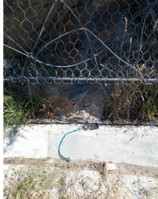
Figura 26 - Local4 (Zona B). Pormenor da linha de água e vegetação à esquerda e da proximidade da rede de torção com o chão à direita.
