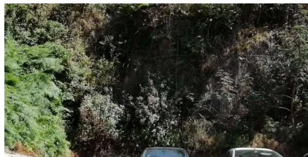
Figura 50- Local não estudado na Arrábida. Pormenor da rede.
