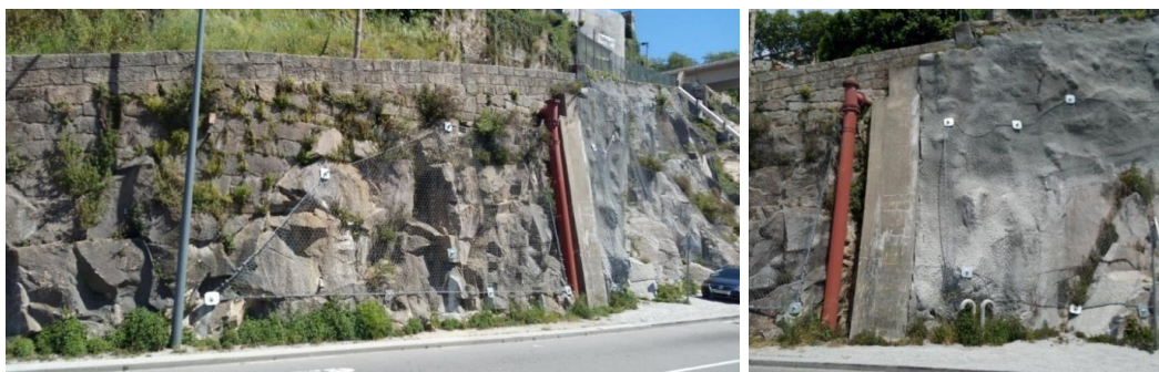
Figura 19- Local P2 (Zona A) com rede e pregagens (à esquerda) e muro de betão (à direita).
