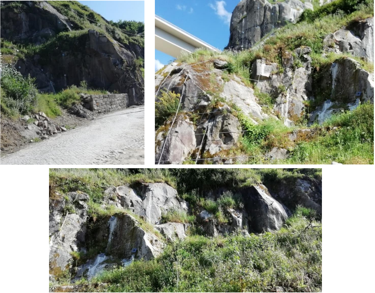
Figura 35 - Local SP3 (Zona A). Pormenor da rede à direita e das cordas e pregagens à esquerda.
