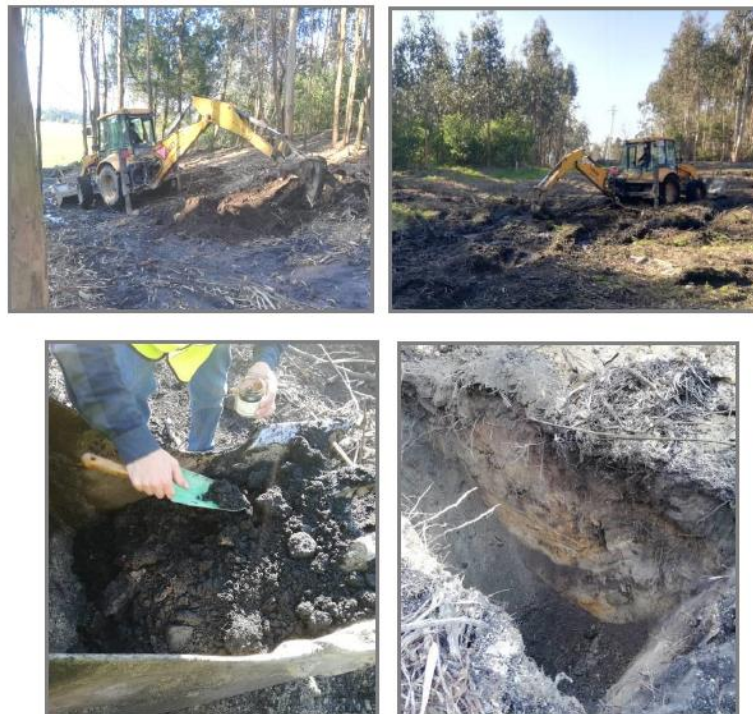
Figura 3 – Fotos ilustrativas do decorrer dos trabalhos executados
