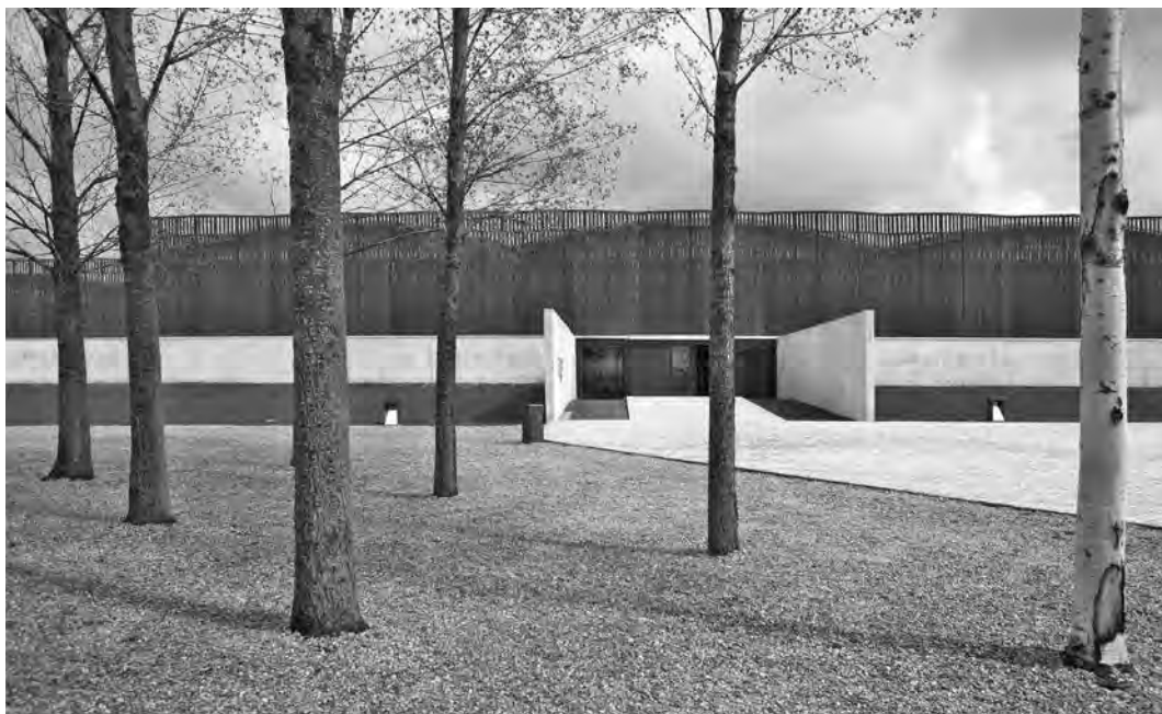
11. Paredes Pedrosa, Museo e Centro accoglienza dei visitatori della villa romana La Olmeda, Palencia, Spagna, 2000-2009. Accesso all'edificio che contiene i resti archeologici. Foto Luis Asín.
