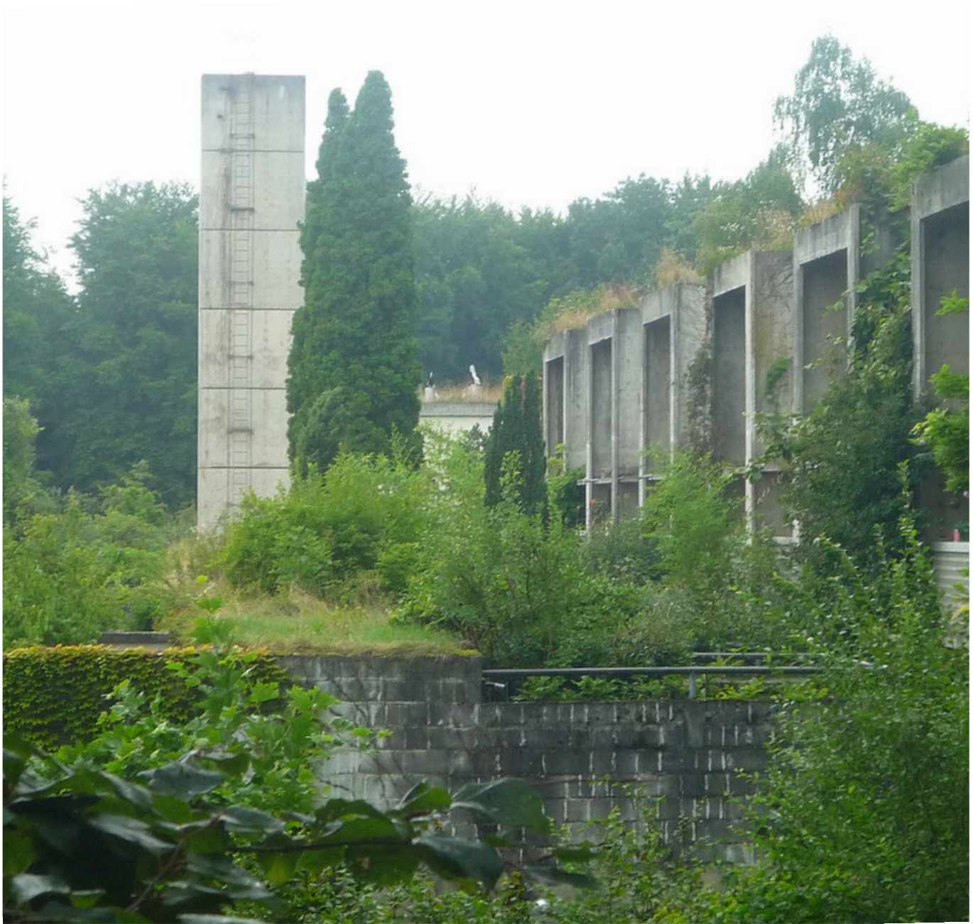
35. Vista da construção já habitada, onde o meio natural atua e cresce sobre as fronteiras privadas
