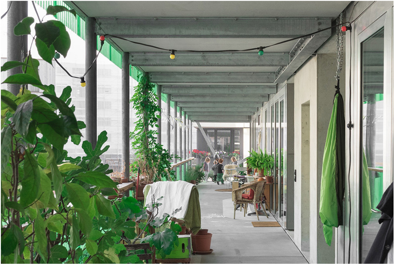
26. Edificio Cooperativa Stadterle, Basel.
