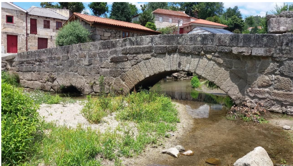
Figura 14: Deposição e acumulação de sedimentos, resultando na formação de curvaturas ao longo do rio.
