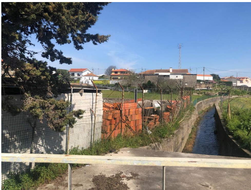
FIG. 5 – Foto ribeira entulhos nas margens (Fonte: autor)
