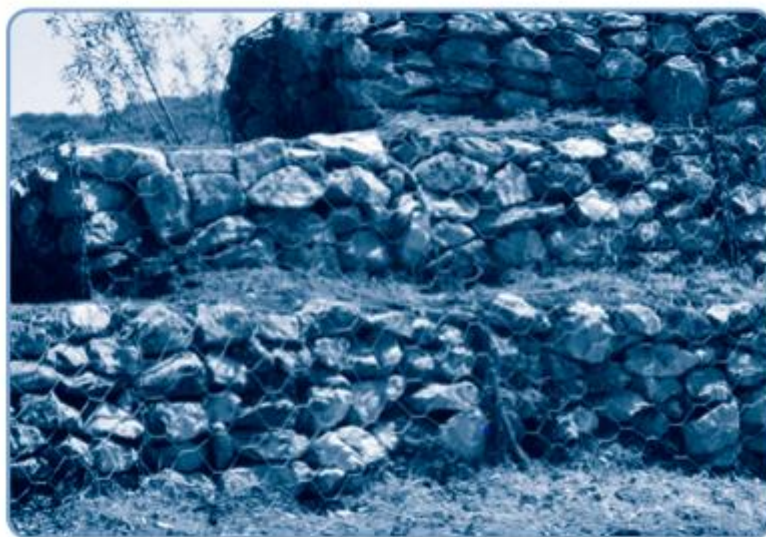
Figura 4 - Muro de Gabião (autor: Amorim, 2018)
