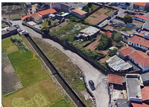
Troço 05 - Vista área - Ribeira, campo agrícola e via de automóveis sem passeios para peões (fonte: google earth)
