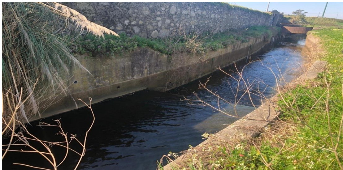
Figura 36 - Passadiço 1 em metal - Ribeira Joane - Troço 1a (fonte: autor)
