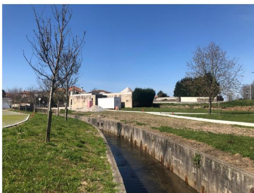
Troço 07 - Vista para a capela mortuária
