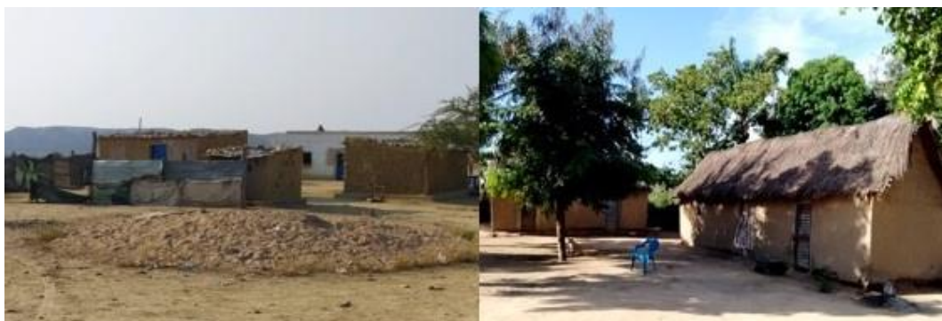
Figura 12: Edificações próximas da cidade de Benguela
