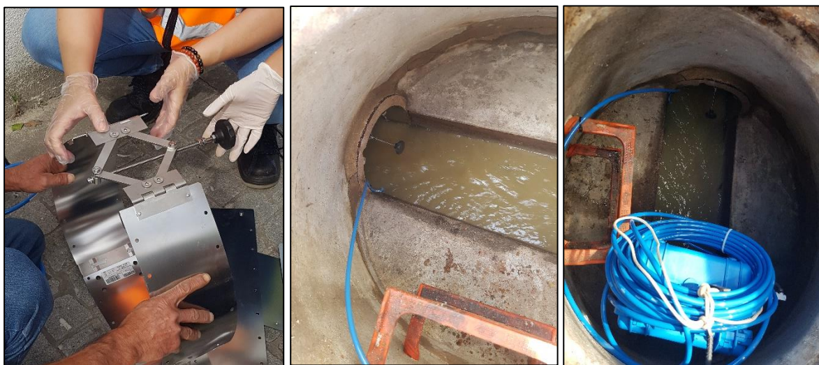
Figura 26: a) Montagem do anel metálico; b) Colocação do anel no coletor, c) Suporte do sistema de medição.
