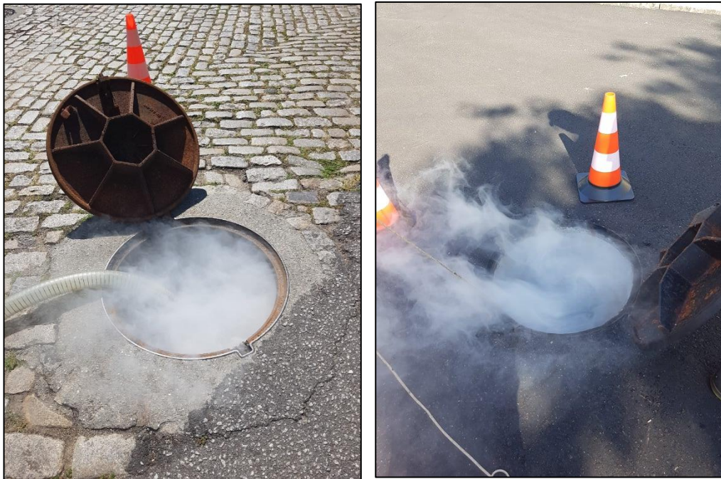
Figura 36: Introdução de fumo na caixa de visita.
