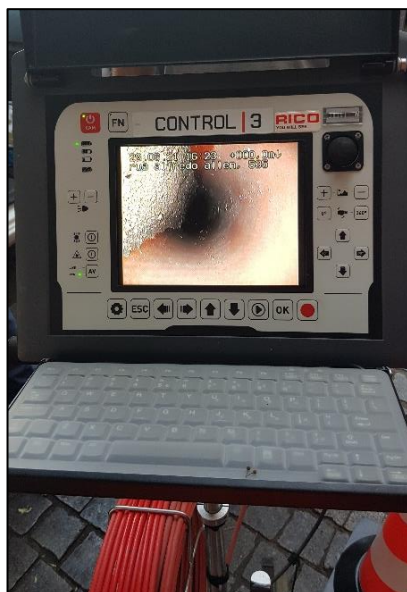
Figura 35: Inspeção vídeo no coletor
