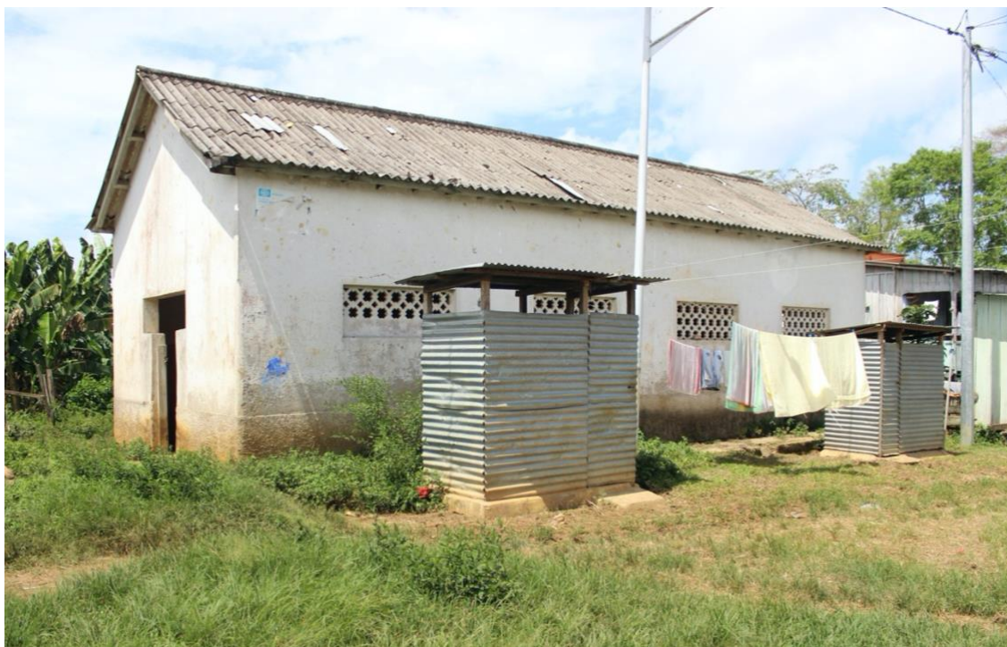
Figura 57 – Cardápio de casas de banho, Anselmo Andrade, Sara Neves, 2017 – Casas de banho individuais em primeiro plano, casas de banho e balneário comuns em segundo plano
