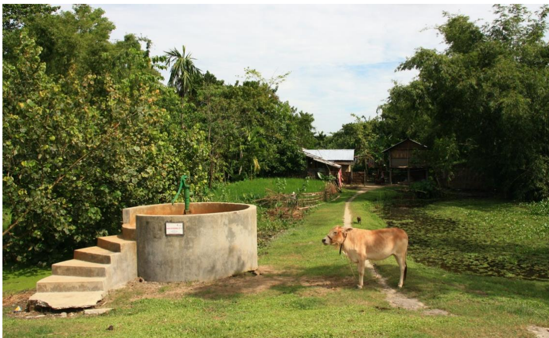
Figura 45 – Collective Shang-handpump , Ahomoni Miri, Sara Neves, 2018 – Bomba manual de extração de água, elevada do solo ( shang ) para o abastecimento durante as inundações
