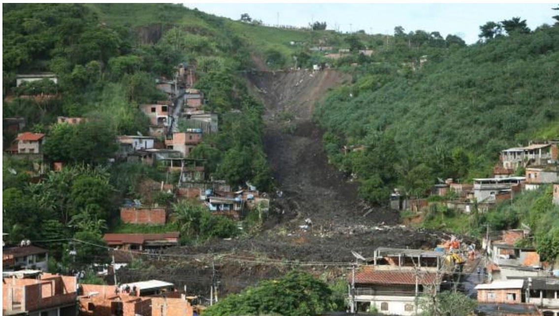
Figura 22: Deslizamento de terra no Morro do Bumba em 2010 no município de Niterói. Fonte: https://extra.globo.com/noticias/rio/oito-anos-depois-de-tragedia-no-bumba-niteroi-ainda-tem-casas-em-areas-de-risco-22562698.html . Foto: Márcia Foletto.
