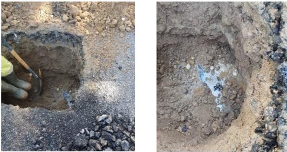
Fig. 32 - Exemplo de perdas reais em ramais de ligação.
