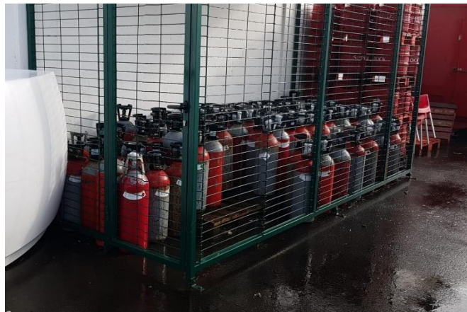
Figura 31 - Garrafas de CO 2 que podem originar explosão e consequentemente morte
