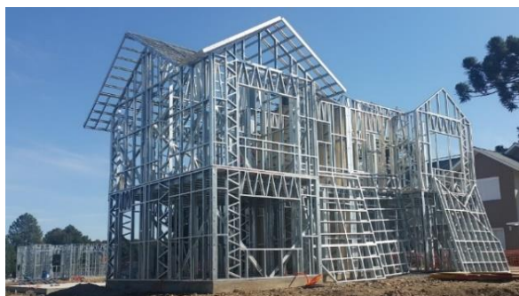
Figura 1 - Estrutura leve em aço [3].
