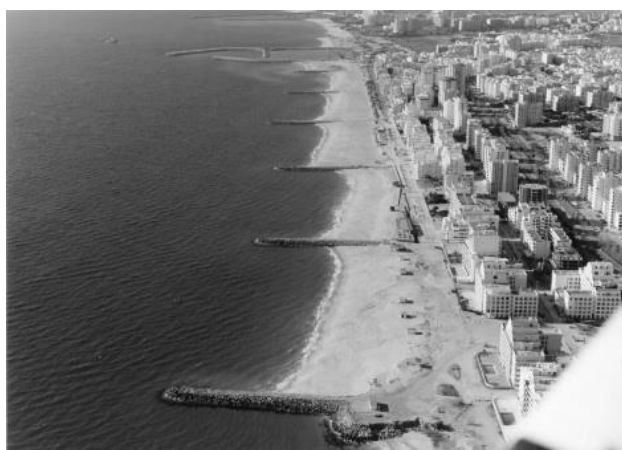
Figura 2.13 - Praia da Quarteira depois da construção do campo de esporões na década de 1970 (Taborda et al. , 2005).
