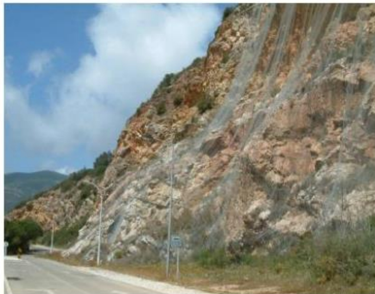
Figura 8.14 – Exemplo de uma aplicação de redes metálicas num talude rochoso. (A. Pinto, 2012)
