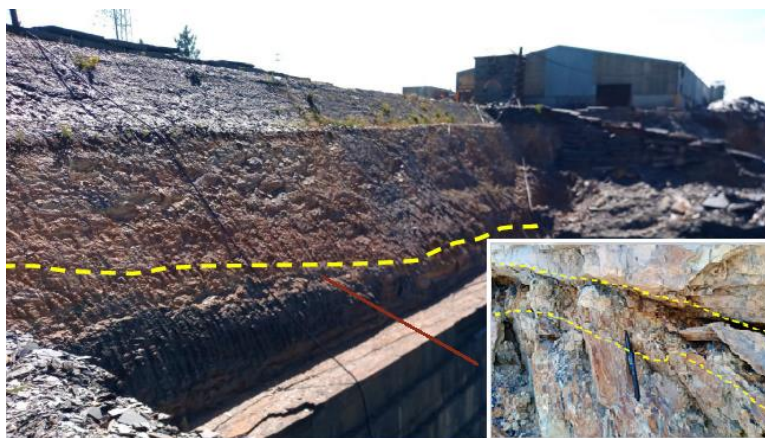
Figura 10.4 – Panorama do Talude Nascente da Zona A e, respetivo, aspeto da falha N150/30E. (Adaptado: Geotek, 2021)
