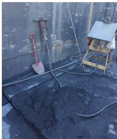
Figura 9.11 – Rachagem do bloco por intermédio de martelos pneumáticos.
