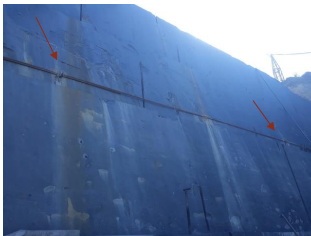
Figura 9.14 – “Slip-set” empregue na pedreira.
