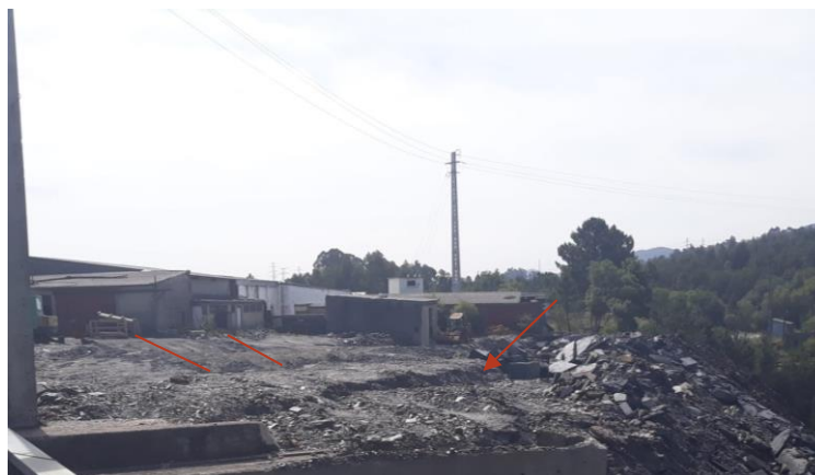
Figura 9.23 – Visualização de desníveis e fissuras no solo resultante do enchimento do vazio inferior do Hasteal SE.
