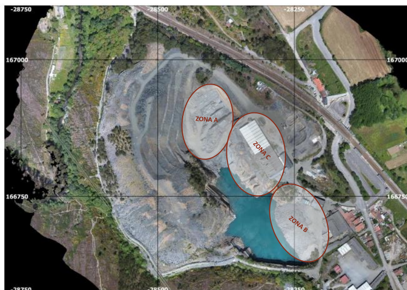
Figura 9.6 – Vista área da Pedreira da Milhária e suas respectivas áreas de desenvolvimento. ( Adaptado: Geotek, 2021 )
