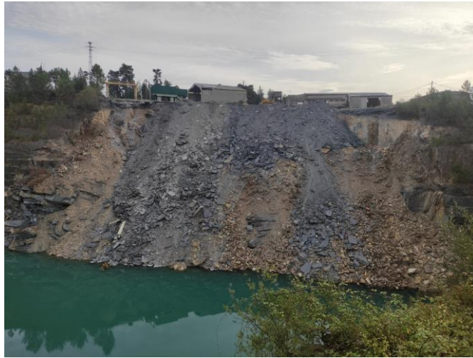
Figura 9.19 – Enchimento da área inferior do Hasteal SE.
