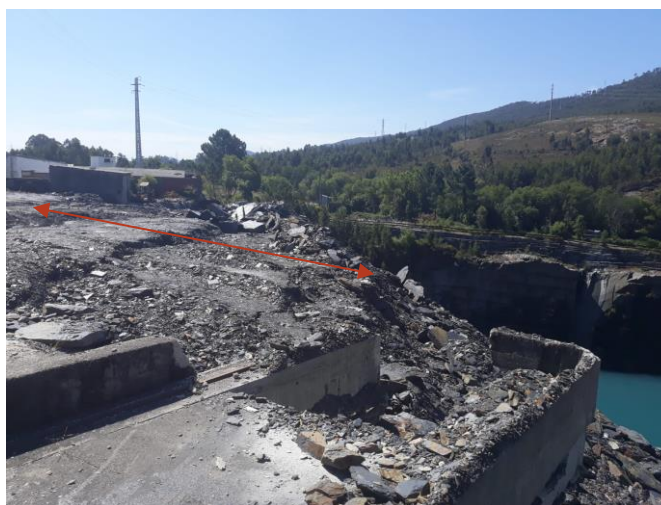
Figura 9.22 – Variação do enchimento, a nível de comprimento, do vazio inferior do Hasteal SE.
