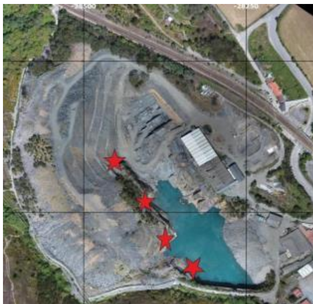
Figura 9.26 – Locais de elevada propensão a queda de blocos. ( Adaptado: Geotek, 2021 )
