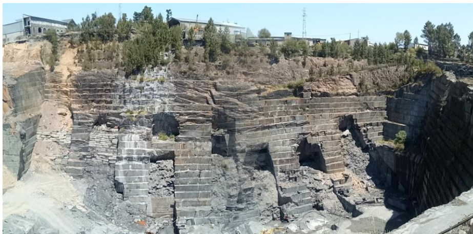
Figura 9.17 – Área B e, por conseguinte, o Hasteal SE antes do desabamento.
