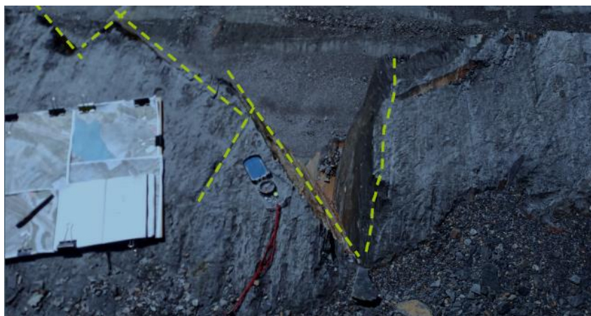
Figura 10.2 – Aspetto de formação de uma qualquer cunha no talude NW na Zona A. (Geotek, 2021)
