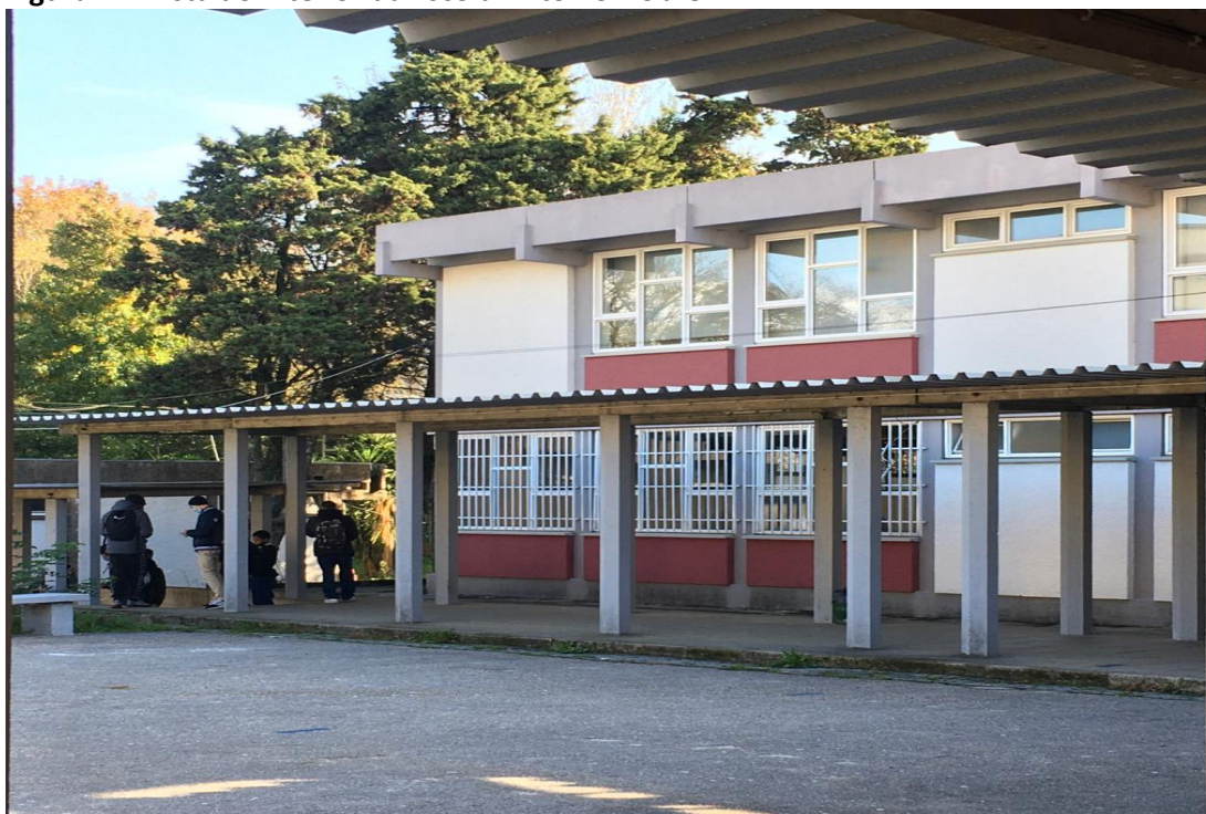
Figura 1 – Vista do interior da Escola António Nobre
