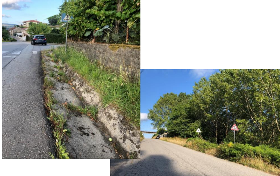
Fig. 14 - Duas zonas distintas de circulação e atravessamento de peões, com elevadas condições de insegurança (fotografias da autora)
