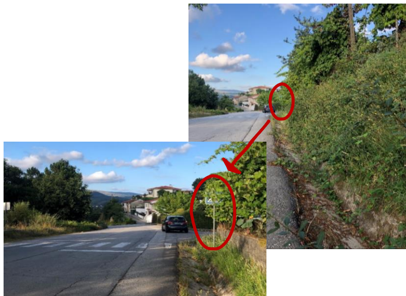
Fig. 16 - Visibilidade de sinalização de travessia para peões, numa zona rural (fotografias da autora)
