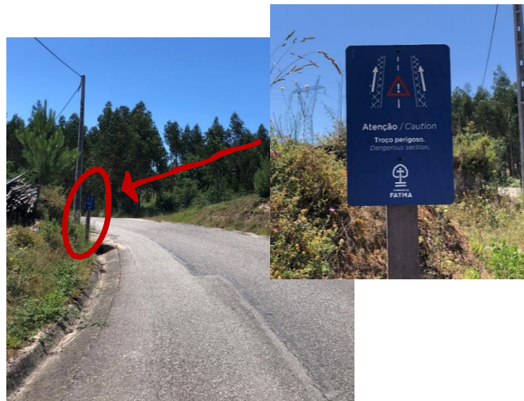
Fig. 13 - Sinalética de perigo apenas para peões e com reduzida visibilidade (fotografias da autora)
