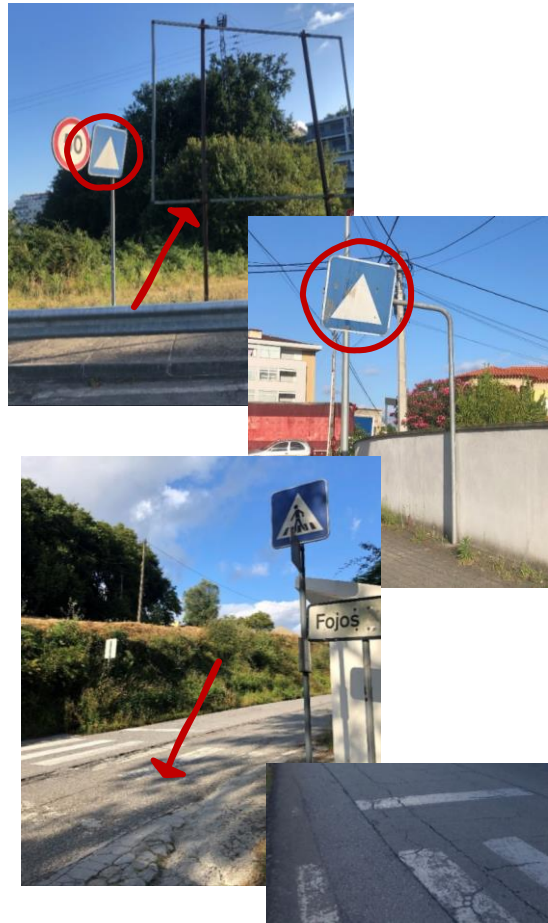
Fig. 17 - Alguns exemplos de degradação da sinalização vertical e horizontal em áreas rurais (fotografias da autora)
