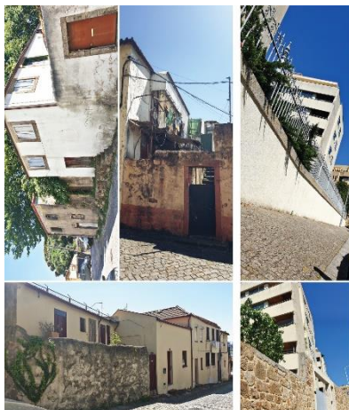
Fig. 7- Rua do Aleixo. Urban facades.
