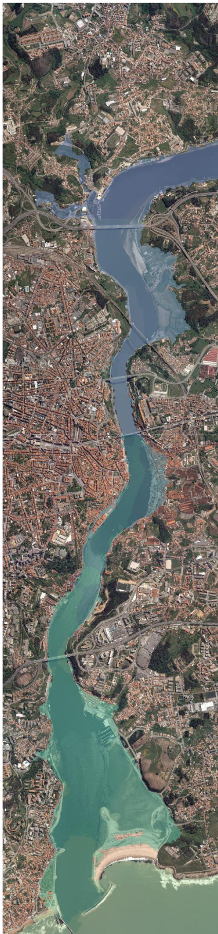
Figura C11: Cenário C11. Zonas inundadas desde os quebra-mares até montante da Ponte do Freixo.
