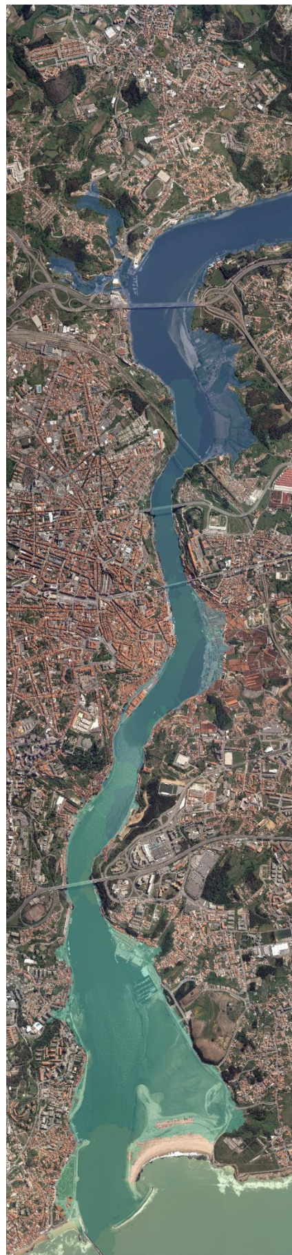
Figura C8: Cenário C8. Zonas inundadas desde os quebra-mares até montante da Ponte do Freixo.
