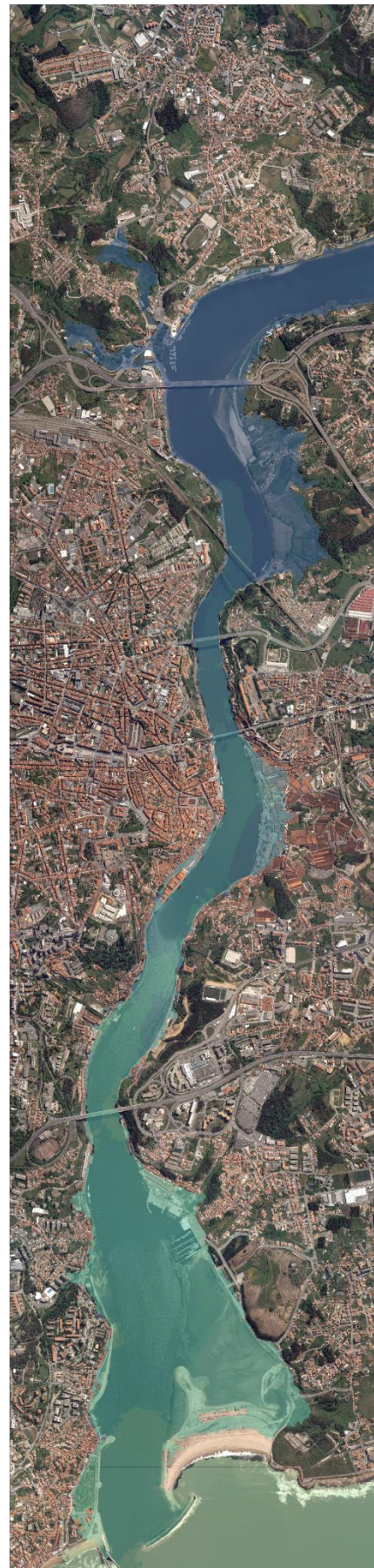
Figura C2: Cenário C2. Zonas inundadas desde os quebra-mares até montante da Ponte do Freixo.
