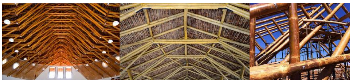
Fig. 7.40 Coberturas dos edifícios do centro de referência [61]
