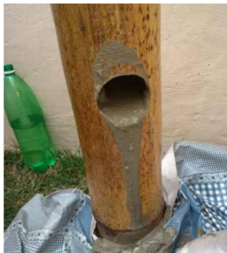
Fig. 6.8 Preenchimento da ligação fundação/pilar [34]
