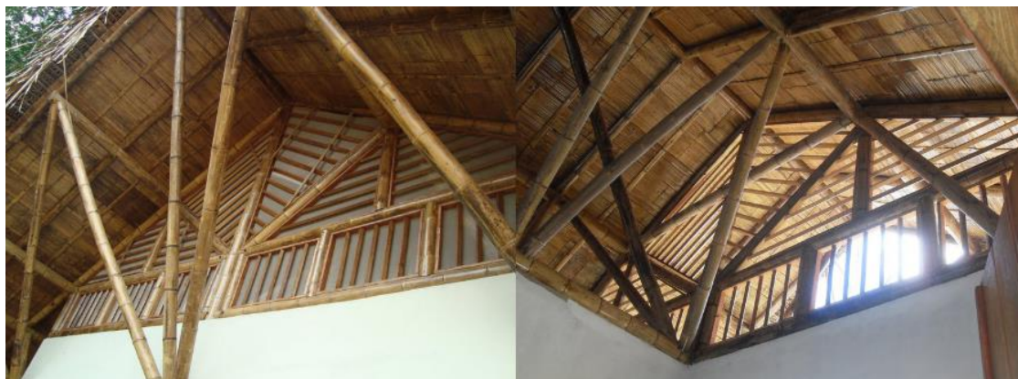
Fig. 7.23 Pormenores da ligação alvenaria/cobertura [57]
