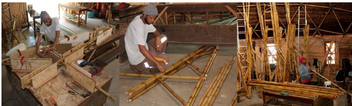
Fig. 7.33 Pré-fabricação das peças [60]
