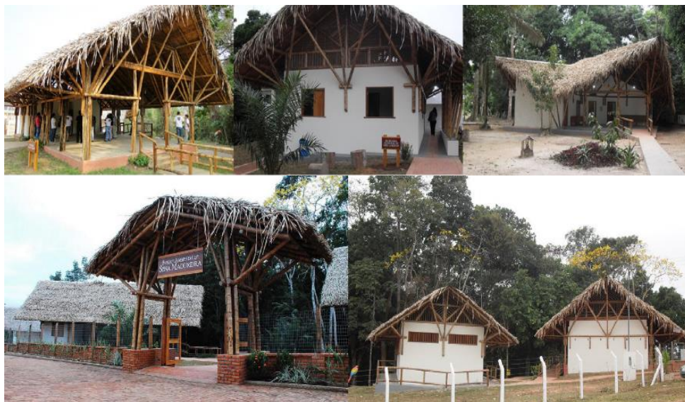
Fig. 7.20 Construções no parque Padre Paolino [57]
