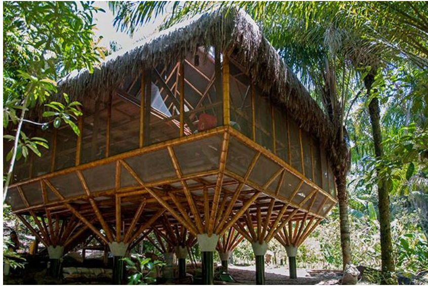
Fig. 7.14 Módulo de 6,40m x 6,40m [55]
