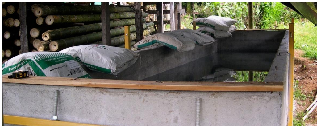
Fig. 4.16 Reservatório e produtos químicos para tratamento de bambu [33]
