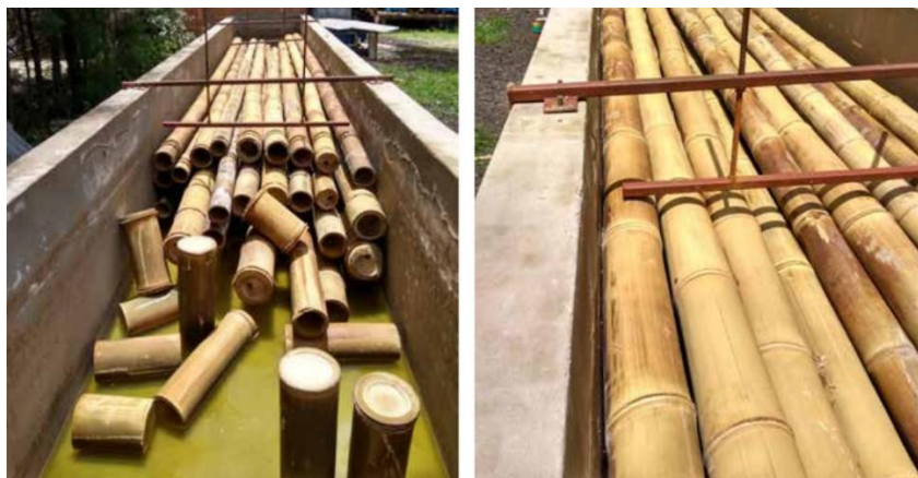
Fig. 4.17 Reservatório para tratamento por imersão com uso de bórax e ácido bórico [34]
