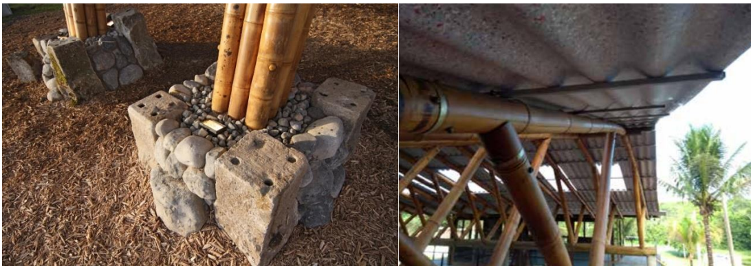
Fig. 4.14 Bases de elevação para pilares; Estrutura de bambu protegida por beiral da cobertura [40]
