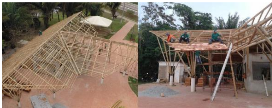
Fig. 7.26 Estrutura da cobertura [57]
