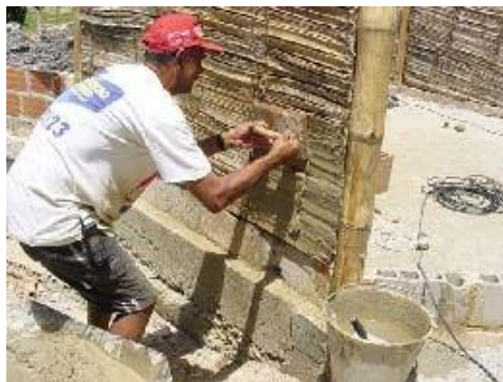
Fig. 7.19 Aplicação de argamassa [56]
