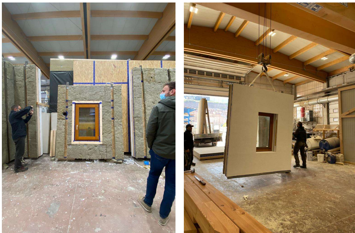
Fig. A1. Montagem em fábrica
