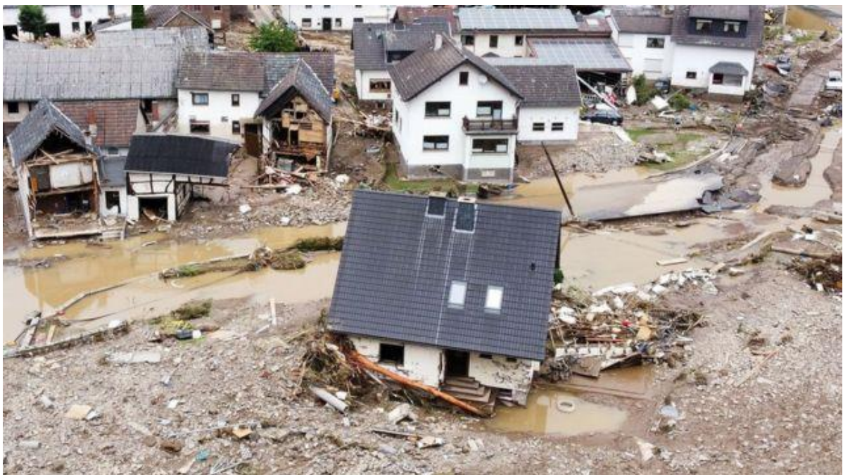
Fig. 1 - Destruição causada por inundação em cidade alemã.
