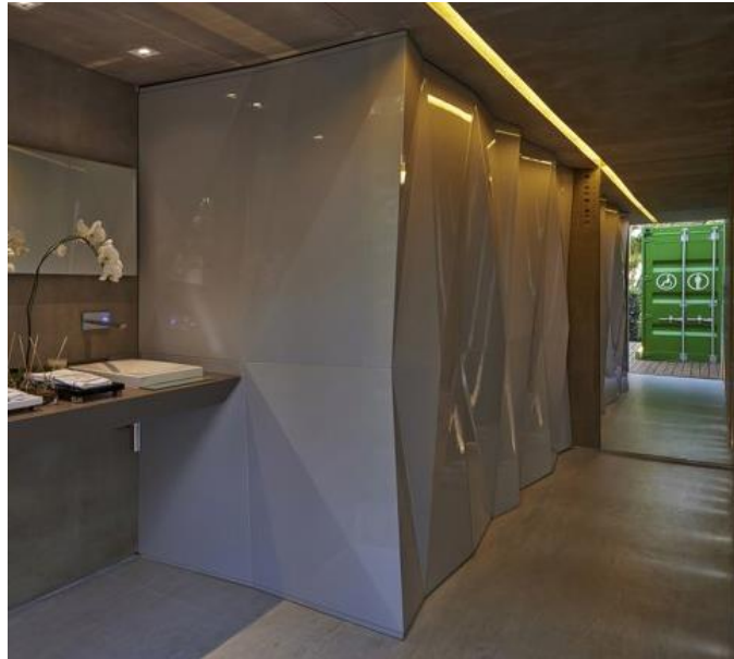
Fig. 13 - Casa de banho com pavimento em painel composto de cimento e madeira. Fonte: Investwood (2021)
