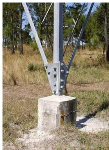
Fig. 3.7 – Apoio da torre
