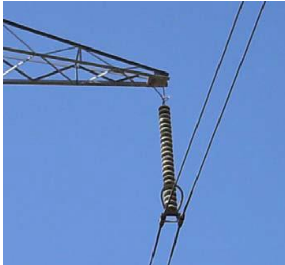
Fig. 3.10 - Ponto de ligação dos fios com a estrutura
