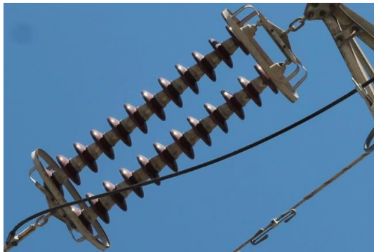
Fig. 3.5 – Pormenor de uma cadeia de isoladores
