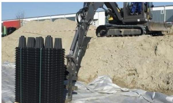
Figura 3.2- Peças que constituem os tanques Stormbrixx (Jornal da Construção, 2020)
