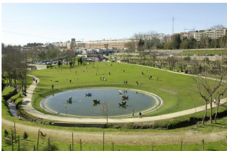
Figura 3.1- Bacia de retenção de céu aberto (Guimarães, 2014)
