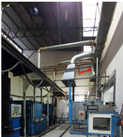
Figura 1.13: Conduta que direciona os gases para o exterior assinalada com uma seta.
