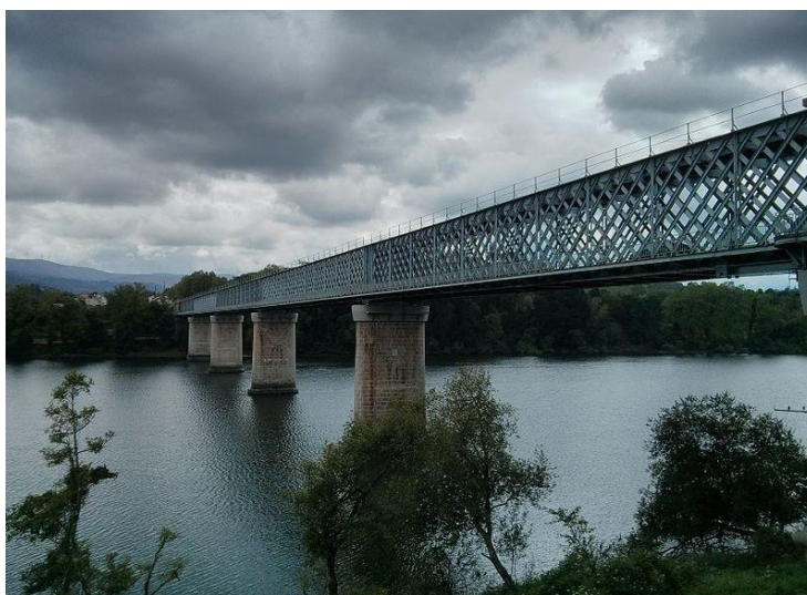
Figura 1.9 - Ponte rodoferroviária de Valença
