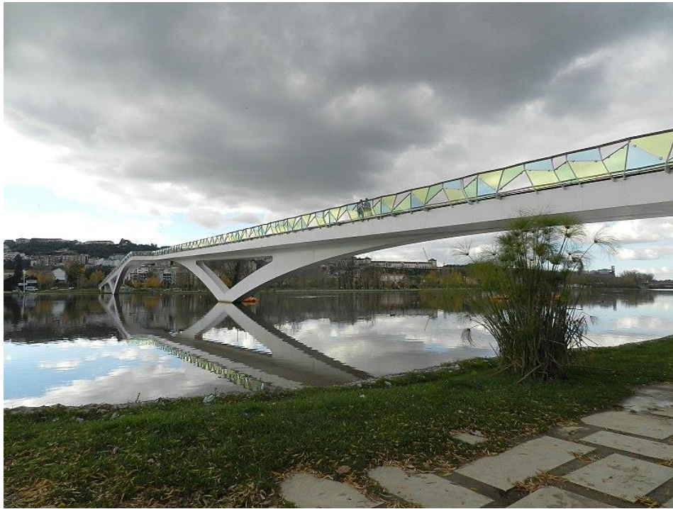
Figura 6.7 - Ponte Pedro e Inês em Coimbra (Iolanda Ogando)
