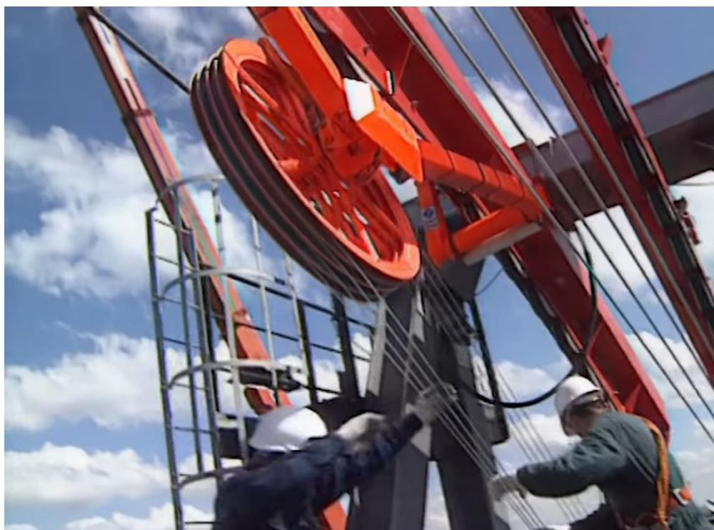
Figura 5.4 - Utilização de cabos-guia para passagem dos cordões de pré-esforço (Spark, 2017)
