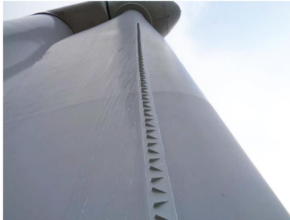
Figura 5 – Aerogerador equipado com vortex generators [8].
