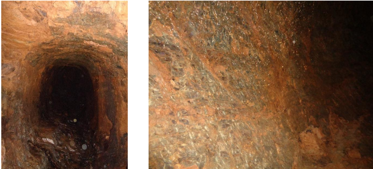
Figura 23 - esq. - Perspetiva da galeria "1" dir.- parede da galeria constituída por blastomilonitos máficos; fotografias cedidas pela Câmara Municipal de Bragança.
