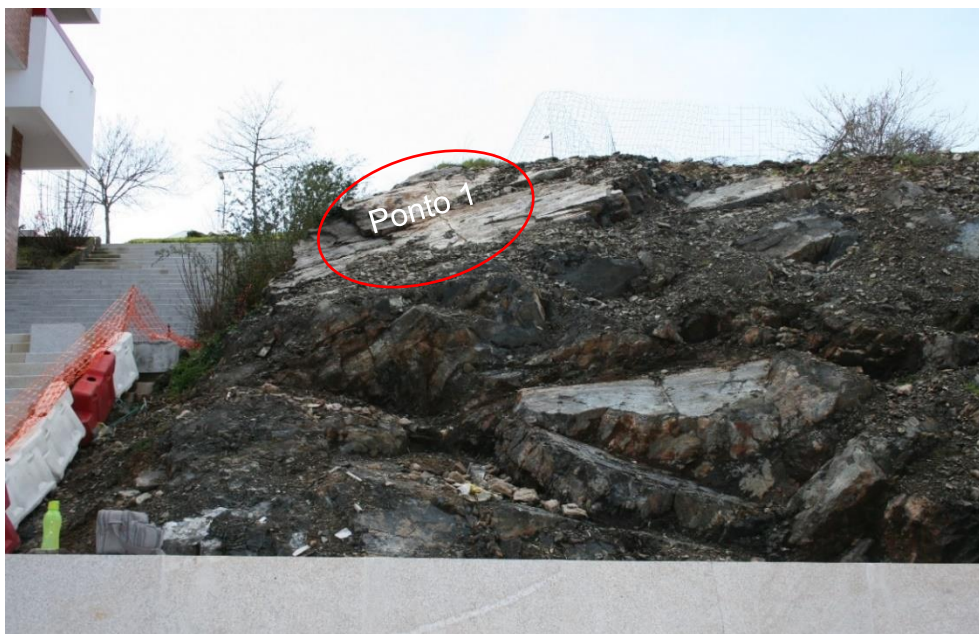
Figura 8 - Localização do Ponto 1; O muro em granito tem a altura 1,50 metros.
