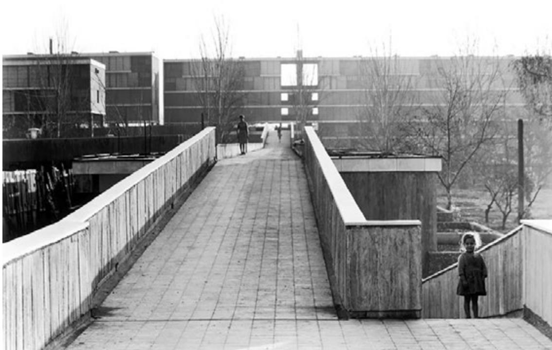
Fig.117 Fotografia da Unidade Vecinal Portales
