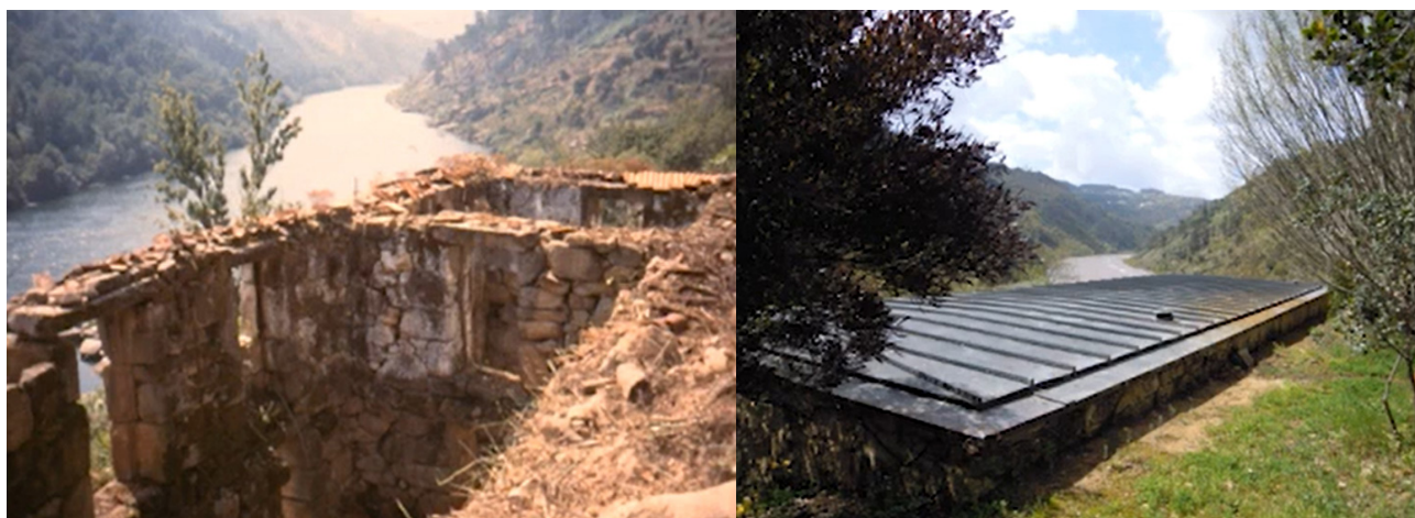
Figura 2. Antes e depois da intervenção. “O volume da casa preexistente foi mantido, mas a sua cobertura atual, plana, denuncia uma vontade de maior integração com a encosta do rio e com a sua superfície plácida.”
