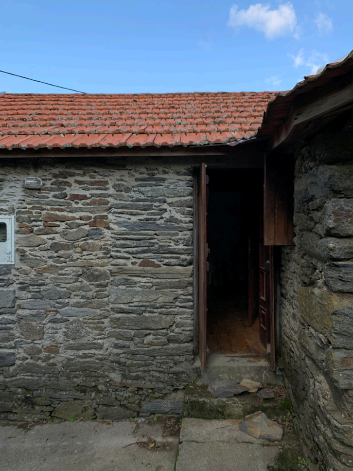
Figura 81. A arquitetura vernacular pode definir-se pela utilização quase exclusiva dos materiais locais. No caso das densas paredes de alvenaria irregular de xisto, que podem em alguns momentos, ultrapassar os 80 centímetros de espessura, são parte vertebral da estrutura desta construção.
