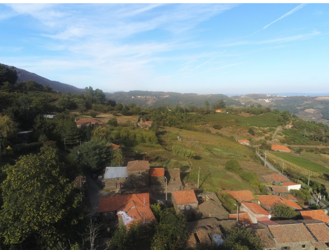
Figura 46. Fotografia aérea de Sudoeste (tirada pelo autor da dissertação) que denota o estado de degradação do património vernacular. Embora sejam identificáveis elementos dissonantes, que foram sendo introduzidas ao longo do tempo nestas construções de génese popular, como a imposição de chapas de zinco ou outros produtos industriais, estas arquiteturas constituem uma relação harmoniosa e equilibrada com o meio onde se inserem.
