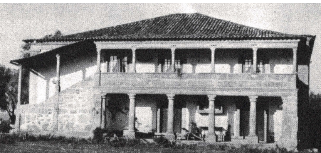
Figura 37. Solar da Quinta do Sabadão, Ponte de Lima.
