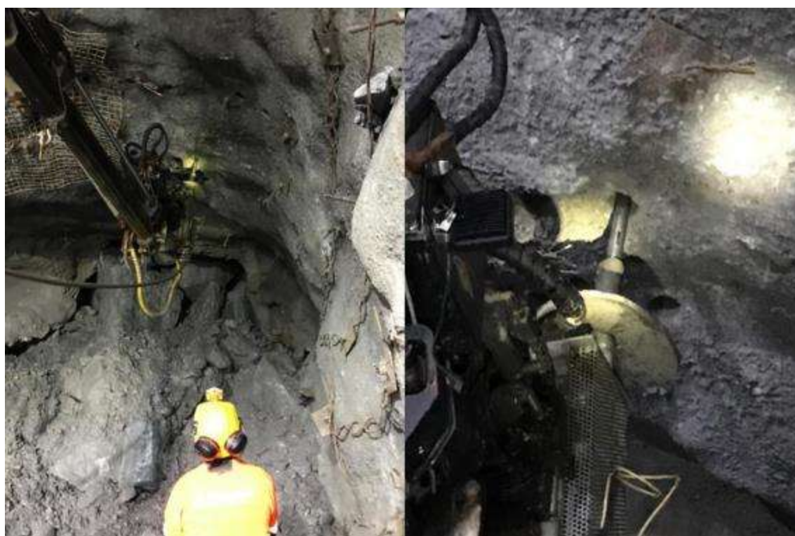
Figura 47 – Registro do uso do desviômetro num furo ascendente de uma obra subterrânea (foto: Jarkko Manninen, Forcit Finlândia)
