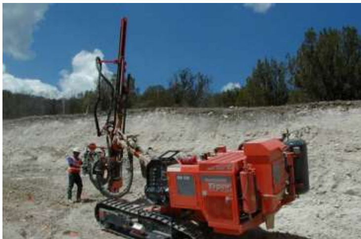
Figura 2 – Exemplo de Carro de Perfuração (Blaster's Training Modules: Blasthole Drilling, 2017)
