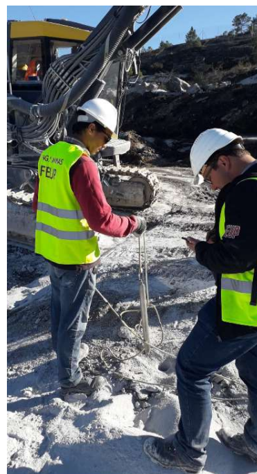
Figura 74 – Um dos registros do teste de fixação dos marcos da corda, com a ajuda de estagiários da O-Pitblast (acervo do autor)
