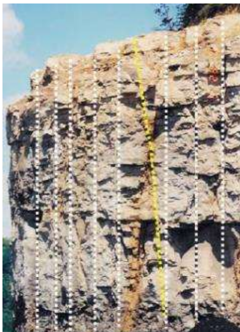
Figura 6 – Exemplo de desvio de furo causado pela transição da rocha (OSMRE, 2017)
