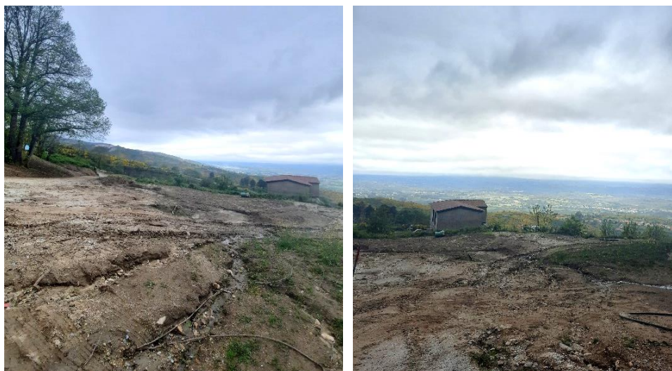
Figura 16 - Problemas de drenagem | Fonte: Autor
