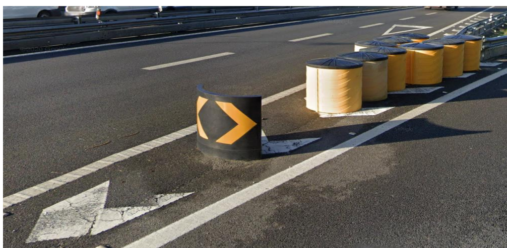
Figura 5.23- Pormenor zona de bifurcação com atenuadores de impacto (Fonte: Google Maps)
