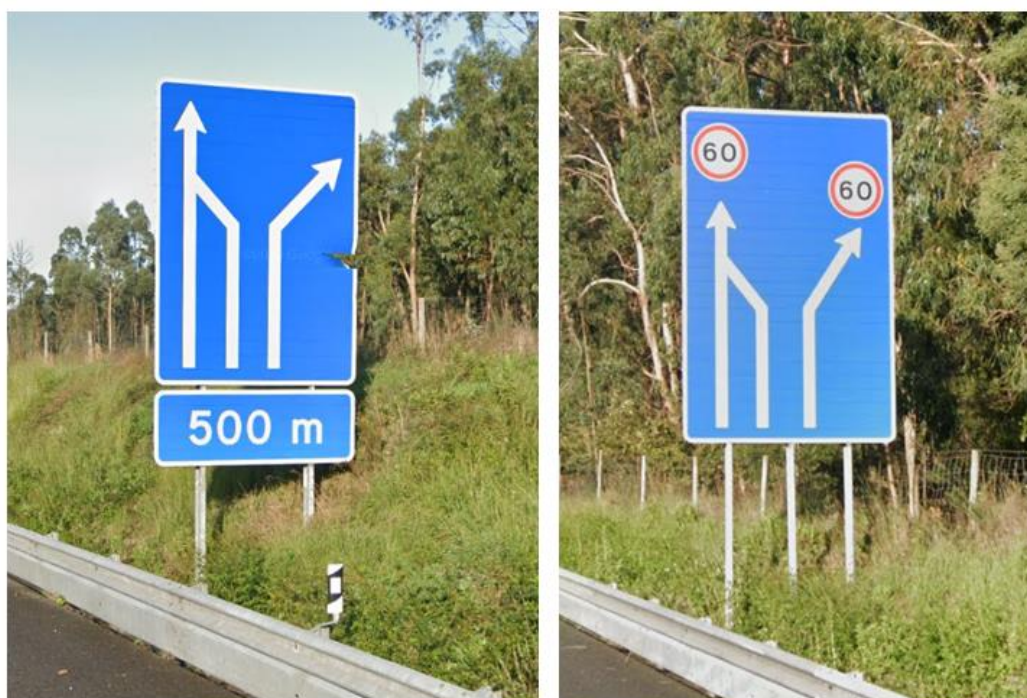
Figura 5.21- Sinalização tipo H32, PK 0+720 e PK 0+520 (Fonte: Google Maps)
