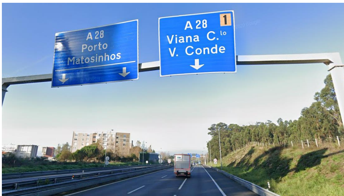
Figura 5.22- Sinalização tipo E1, PK 0+372 (Fonte: Google Maps)
