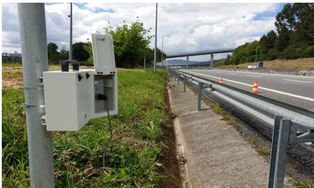
Figura 4.2- Colocação radar no terreno (Fonte: Autor)
