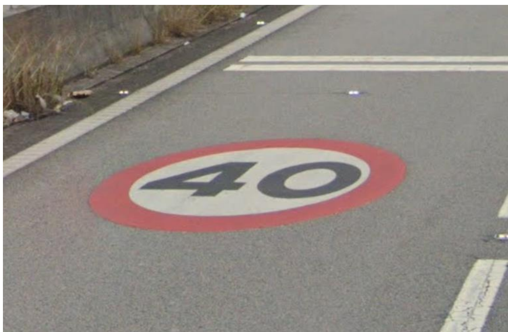
Figura 5.29- Marca no Pavimento de 40 (Fonte: Google maps)
