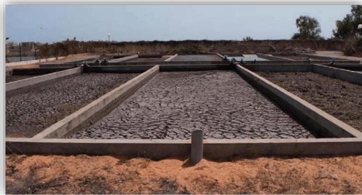
Figura 18 – Leito de secagem aplicado em lamas de ETAR no Senegal
