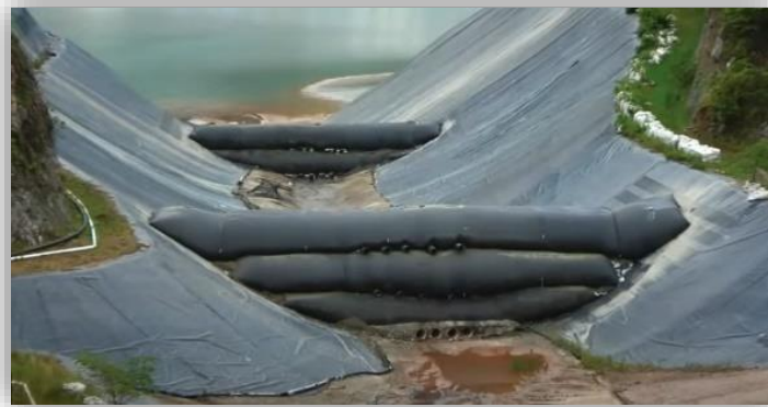
Figura 23 – Utilização de unidades Geotube® contendo lamas desidratadas como barragem. (Tencate Geotube®, 2021)
