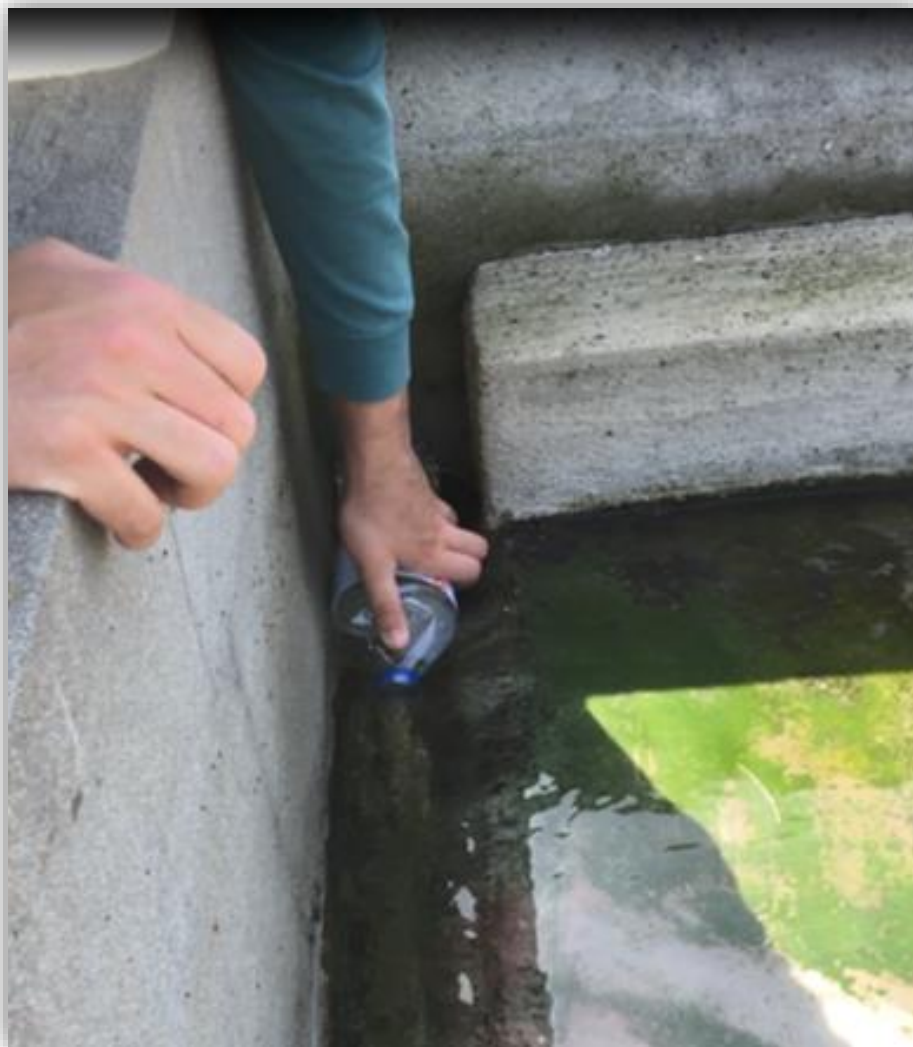
Figura 51 – Recolha de filtrado da unidade Geotube® na Figueira da Foz.
