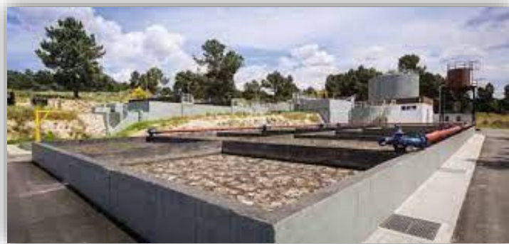
Figura 19 - Leito de secagem de lamas aplicado numa ETAR em Torrão (Águas do Vale do Tejo, 2020)
