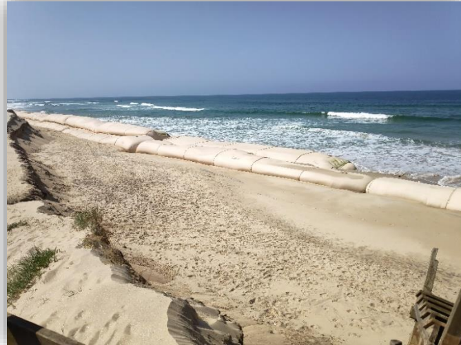
Figura 35 – Exemplo da utilização de unidades Geotube® no combate à erosão costeira.
