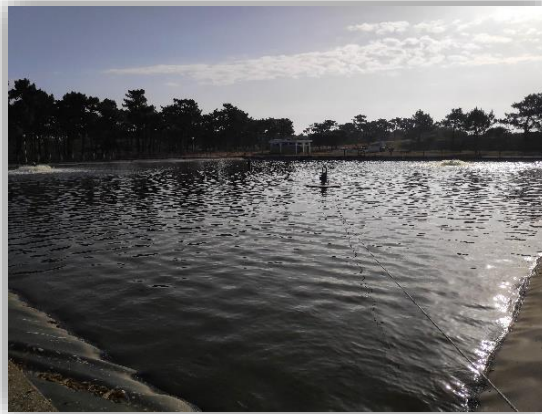
Figura 10 – Tratamento por lagunagem numa ETAR.
