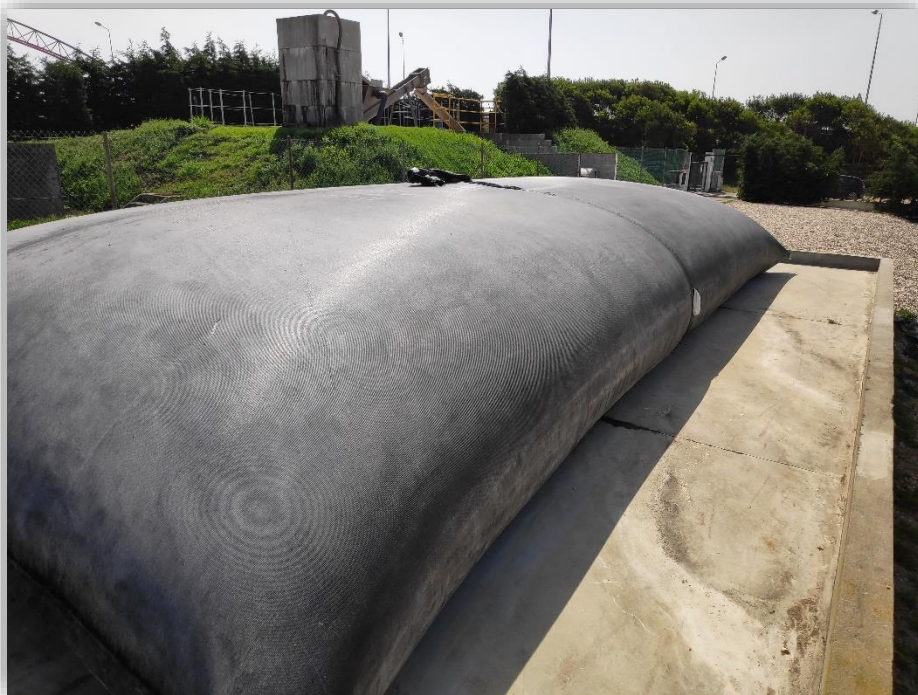
Figura 26 – Unidade Geotube® com costuras circunferenciais na estrutura.
