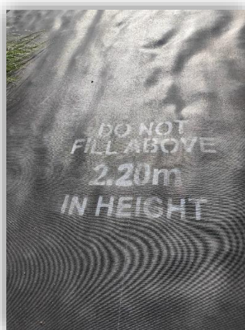
Figura 27 – Altura máxima de enchimento gravada na superfície da unidade Geotube®.
