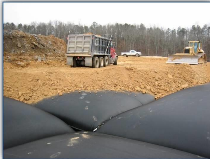
Figura 24 – Utilização de unidades Geotube® contendo lamas desidratadas para terraplanagem. (Tencate Geotube® Case Studies, 2021)
