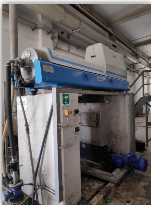
Figura 48 – Centrifugadora de lamas na ETAR em Famalicão.
