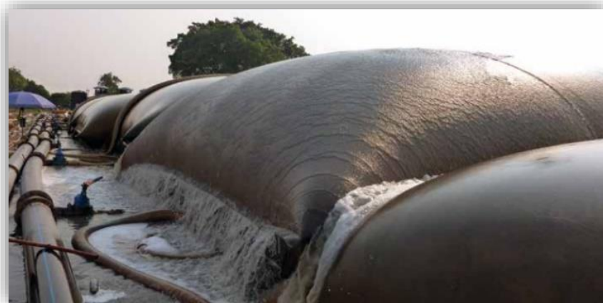
Figura 36 – Aplicação da tecnologia Tencate Geotube® na remediação de um rio na Malásia (Tencate Geotube® Case Studies, 2021).
