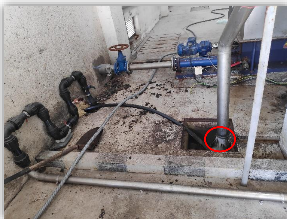
Figura 53 – Ponto de amostragem onde foi retirado o centrifugado da ETAR em Famalicão.
