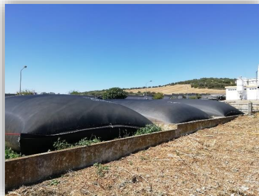
Figura 29 - Aplicação de unidades Geotube® em leitos de secagem (Tencate Geotube®, 2021)
