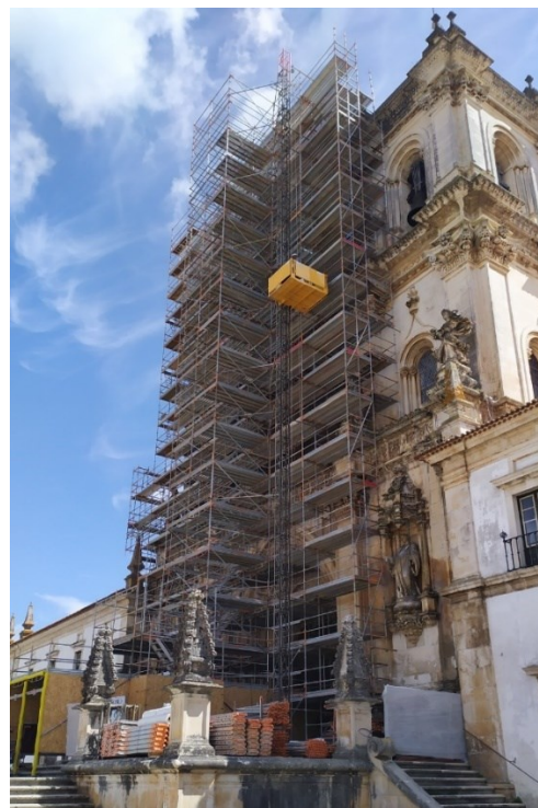
Figura 3.18 – Exemplo de andaime para instalação de monta cargas [64]
