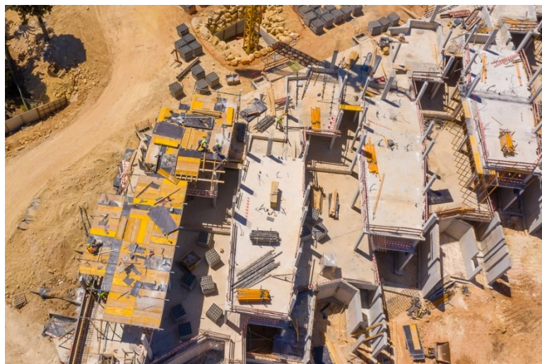
Figura 5.36 - Vista aérea de alguns apartamentos da obra Palmares Resort
