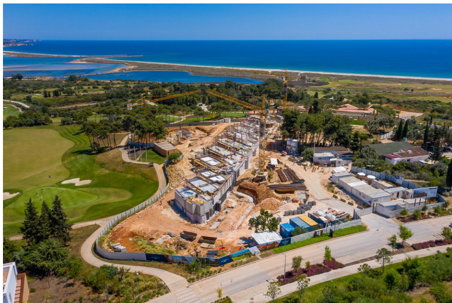
Figura 5.34 -Obra Palmares Resort
