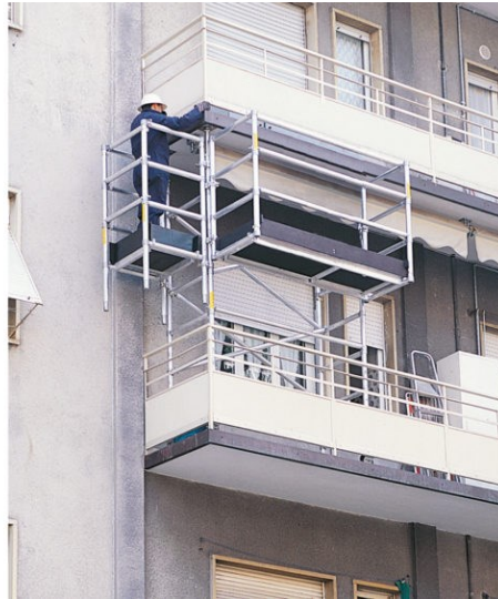
Figura 3.17 - Exemplo de andaimes em saliências na fachada [63]
