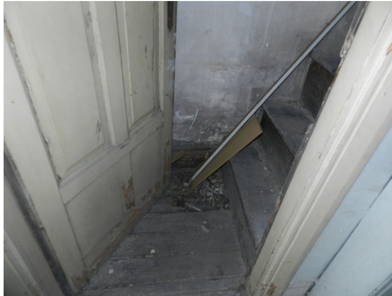
Figura 5.6 - Interior do edifício, pormenor escadas, obra Aliados Plaza Hotel
