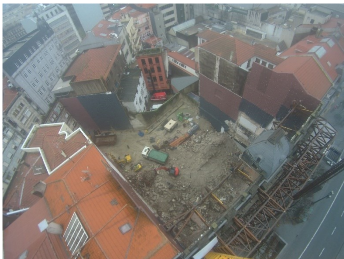
Figura 5.8 – Fase de demolição e contenção das fachadas, obra Aliados Plaza Hotel
