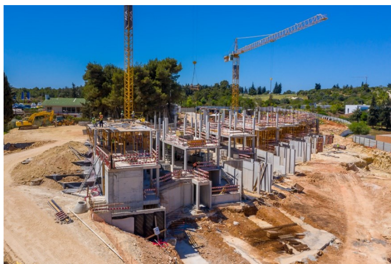
Figura 5.35 - Fotografia retirada na obra Palmares Resort
