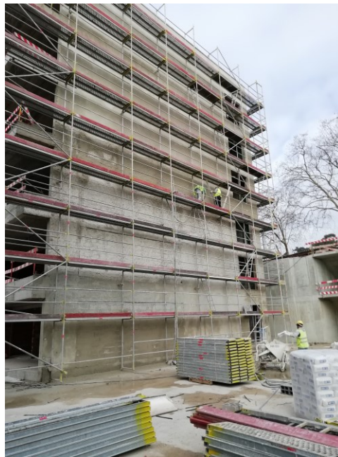
Figura 3.4 - Andaime de fachada - Obra: Ed. Carnaxide, ACA
