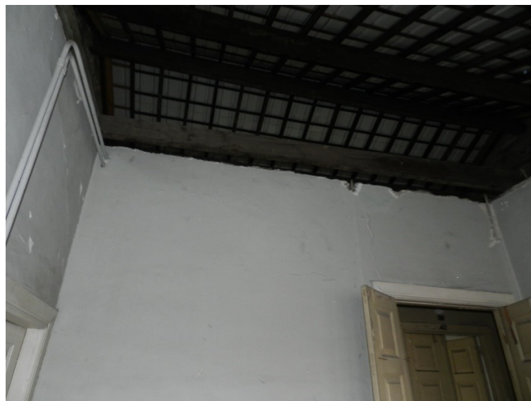
Figura 5.7 - Interior do edifício, pormenor teto, obra Aliados Plaza Hotel
