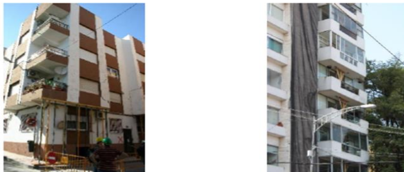
Fig. 14 - Danos nos elementos estruturais secundários Lorca, Espanha, 2011 - México, 2017 (adaptado de Romão et al. 2013, Furtado 2020)
