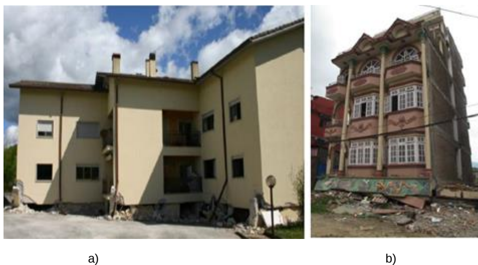
Fig. 11 - Danos associados a irregularidades estruturais, quer em planta quer em altura, resultando em problemas de torção e piso flexível, no-após sismo de: a) L'Aquila, Itália, 2009 e b) Gorkha, Nepal, 2015 (adaptado de Vicente et al. 2012, Varum et al. 2017)
