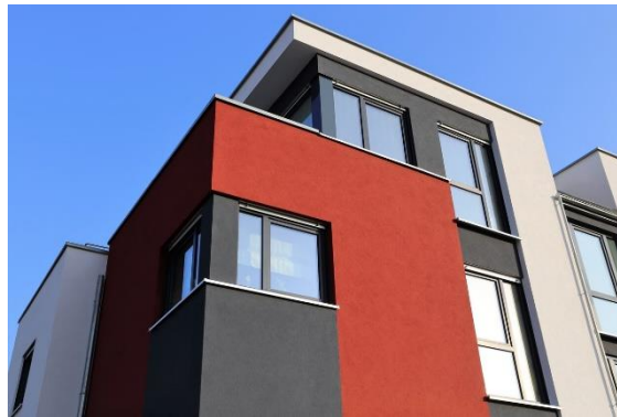
Figura 10 – Fachada com revestimento em pintura (Obrastotais, 2021).
