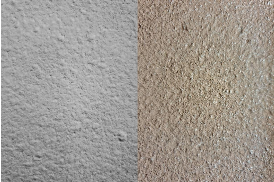
Figura 4.7 – Pormenor de um painel da amostra de Sonacoustic® ALM , onde é visível a massa de barramento antes de qualquer processo (esq.) e após pintura (dir.) [fotos do autor].
