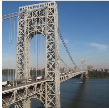
Figura 23 - George Washington Bridge (1931), Nova Iorque, Estados Unidos da América (vão livre de 1067m)
