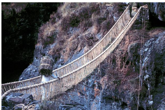
Figura 18 - Exemplo de ponte suspensa simples primitiva
