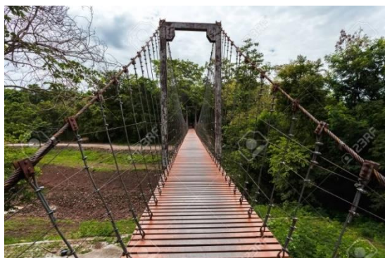
Figura 56 - Exemplo de alinhamento transversal do assoalho de madeira
