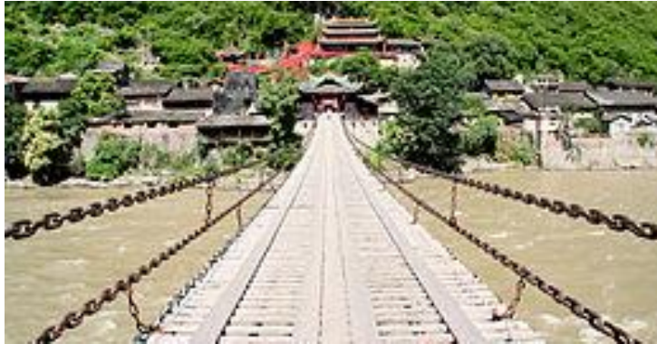
Figura 19 - Ponte pedonal de Luding, China inaugurada em 1701 (vão livre de 100m)
