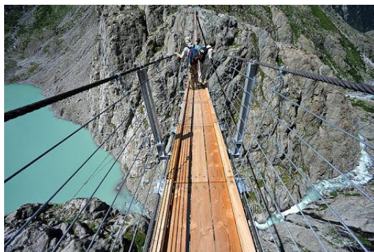
Figura 55 - Exemplo de alinhamento longitudinal do assoalho de madeira
