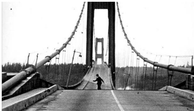
Figura 33 - Tacoma Narrows Bridge (1940), Estados Unidos da América (vão livre de 853m)
