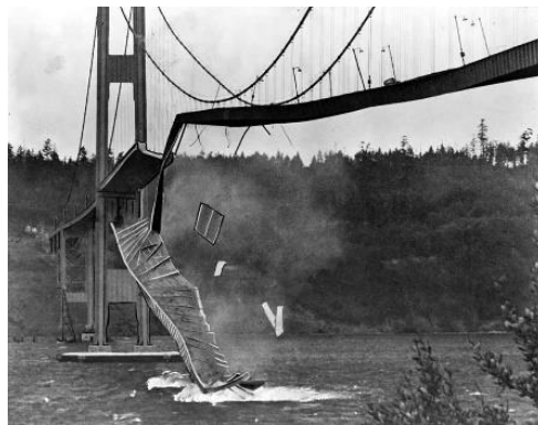
Figura 32 - Tacoma Narrows Bridge (1940), Estados Unidos da América (vão livre de 853m)
