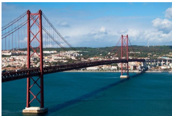
Figura 27 - Ponte 25 de Abril (1966), Lisboa, Portugal (vão livre de 1013m)
