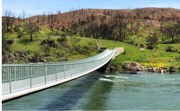
Figura 34 - Exemplo de ponte stress ribbon
