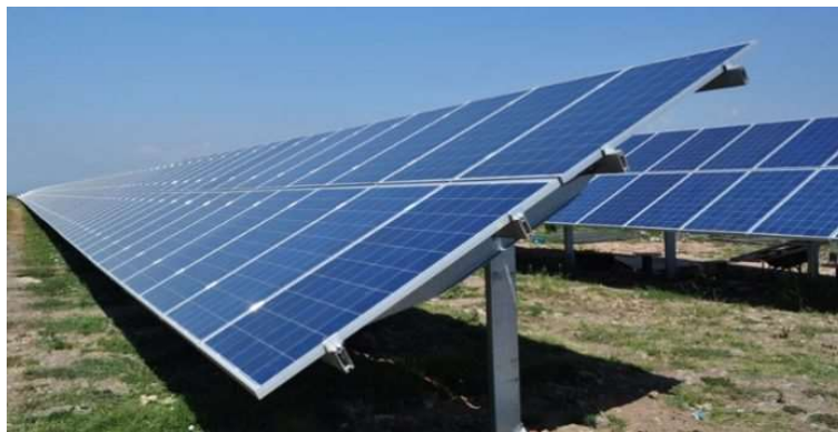
Figura 1.1 - Mesa de painéis fotovoltaicos em parque solar [5]
