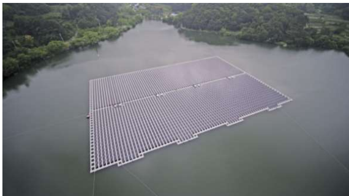
Figura 2.15 – Plataforma flutuante de painéis fotovoltaicos instalada em barragem no Brasil [20]
