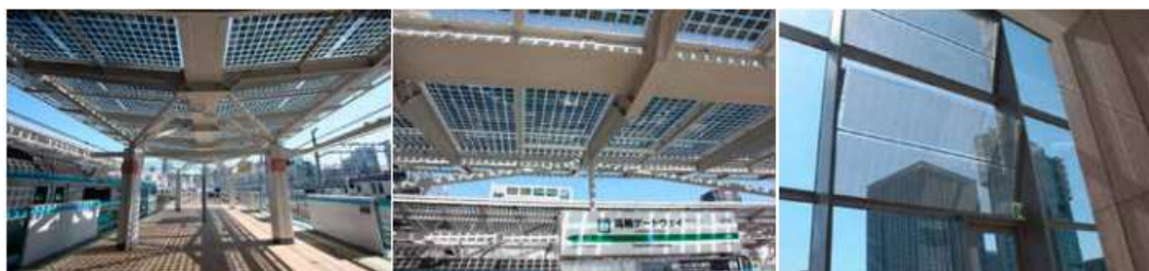
Figura 2.11 – Cobertura (43,8 kW) e janela (1,1 kW) com sistema fotovoltaico integrado ao vidro numa estação de comboio em Tokyo [15]
