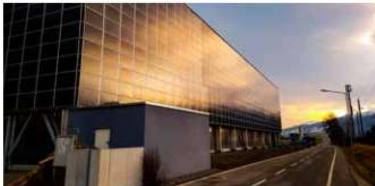
Figura 2.8 – Fachada de edifício de supermercado na Áustria coberta por painéis solares [15]
