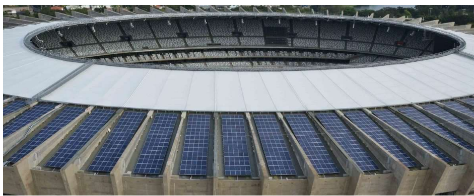
Figura 1.3 – Usina Fotovoltaica instalada na cobertura do estádio Mineirão no Brasil [7]
