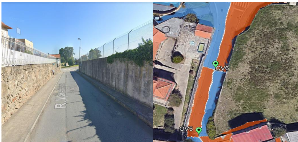
Fotografía 20 - Áreas a drenar a CV6 (Fuente: Google Earth)
