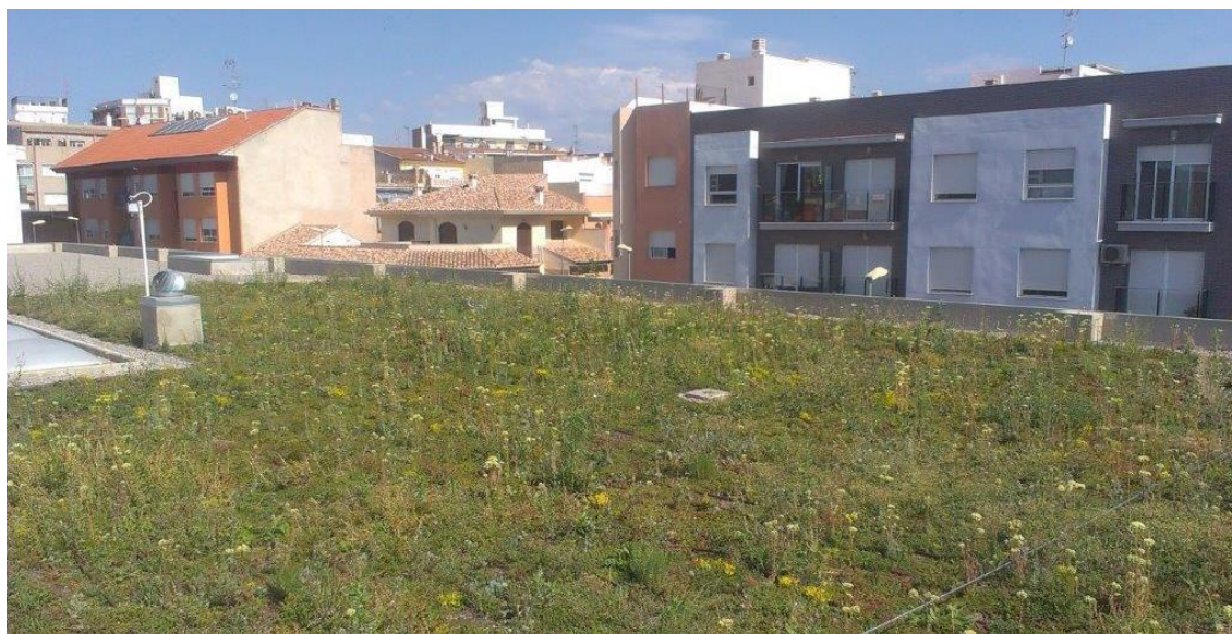
Fotografía 9 – Monitorización cubierta vegetalada (Fuente: Proyecto Aquaval)
