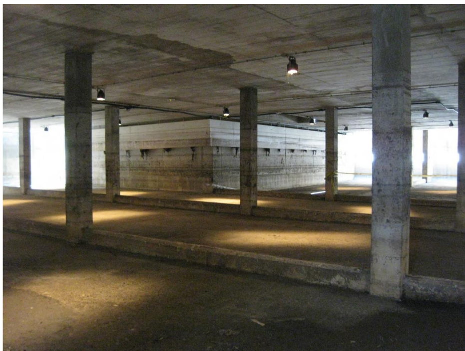
Fotografía 10 – Ejemplo de tanque de tormentas de Cantarranas (Madrid) (Fuente: Manual de recomendaciones de la Subdirección General de Infraestructuras de España)
