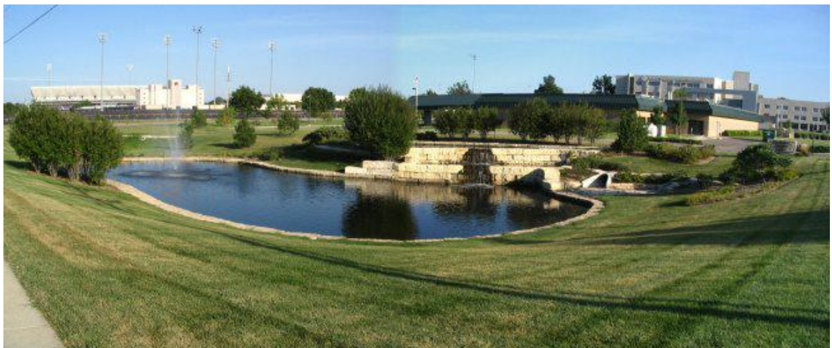
Fotografía 3 – Estanque de retención en una zona deportiva. (Fuente: Gallery New Construction In Manhattan).
