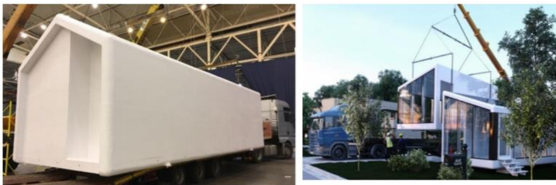
Figura 43 - Módulo pré-fabricado impresso da Haus (Silva, 2020)
