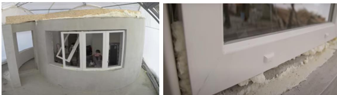
Figura 44 - Instalação de caixilhos em construção 3D (Tecnundo, 2017)
