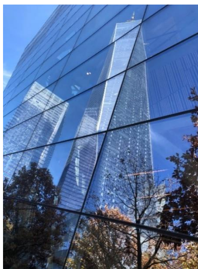
Figura 37 - Edifício com vidro refletivo
