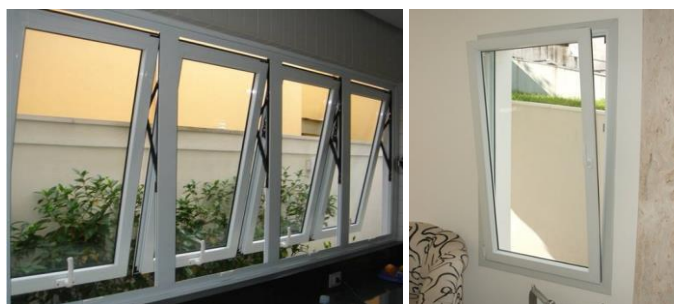
Figura 11 - Janela projetante e janela basculante (Tamires, 2017)
