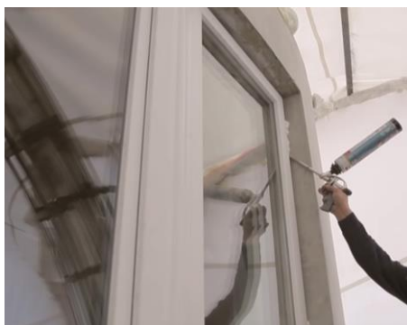
Figura 60 - Aplicação de espuma de poliuretano (Tecnimundo, 2017)
