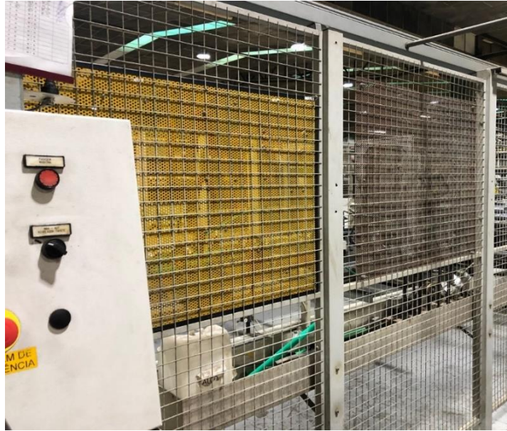
Figura 18 - Vista obstruída pelo quadro de ferramentas na situação inicial
