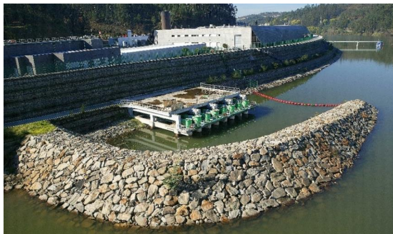
Figura 3 - Captação superficial da ETA de Lever da AdDP (Águas do Douro e Paiva, 2004)
