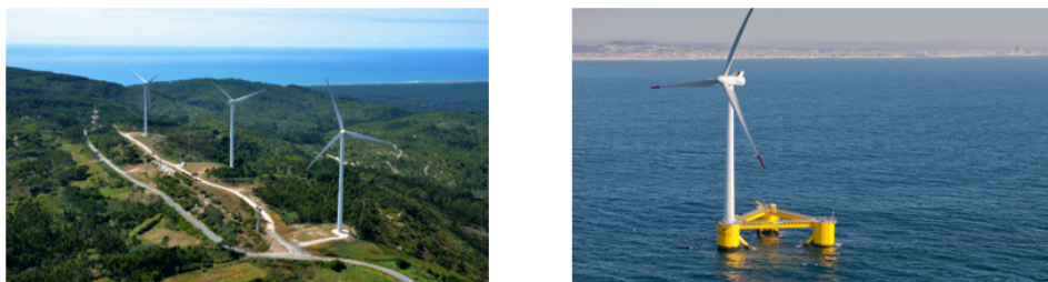
Figura 2.6: Instalação Onshore na Serra da Boa Viagem e Offshore em Viana do Castelo.
