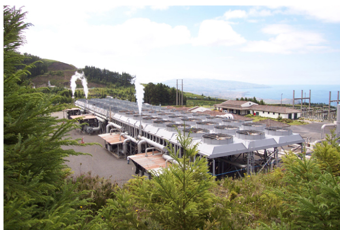
Figura 2.16: Central Geotérmica do Pico Vermelho, em São Miguel, nos Açores. Fonte:[28]
