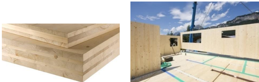
Fig. 32 - Esquerda: Painel estrutural CLT [46]; Direita: Construção de edifício em CLT [47]
