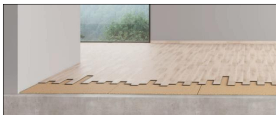
Fig. 18 - Aplicação dos underlays sob o revestimento do piso [22]
