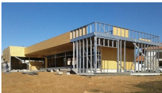
Fig. 34 - Construção em Light Steel Framing [51]
