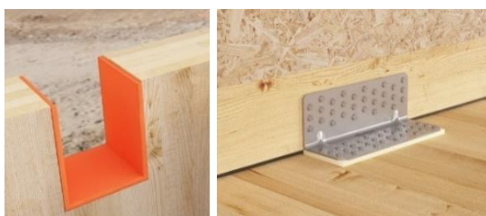
Fig. 59 - Aplicação de materiais de controlo de vibrações no local de assento da viga (esquerda) e em cantoneiras metálicas (direita) [63]
