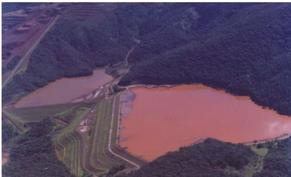
Fig. 2.3 – Barragem de Rejeitos em Brumadinho, (Robertson et al. , 2019)
