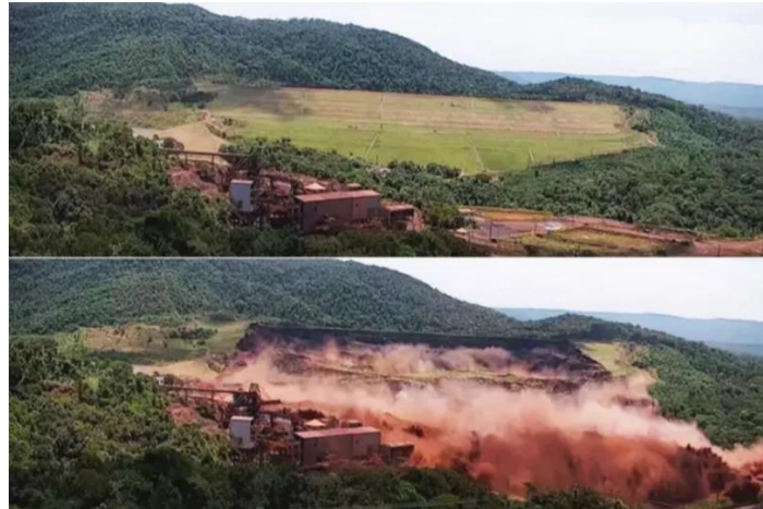
Fig. 3.16 – Ruptura por Liquefação Barragem de Brumadinho (MG), Brasil (2019). (Redação Veja, 2021)
